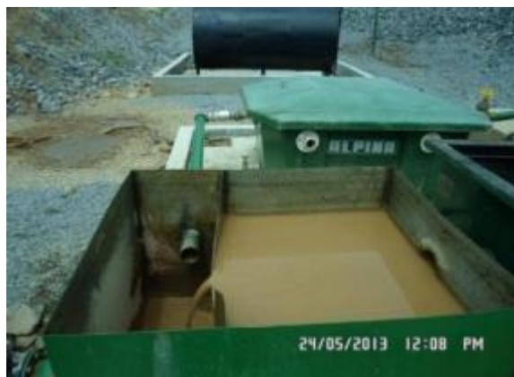
**Figura - 10 – Caixas SAO da Rampa de lavagem/oficina mecânica do Sítio Pimental**
