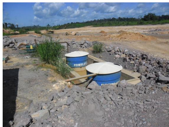
**Figura - 6 – Caixa reservatório para reuso do Sítio Canais e Diques**
