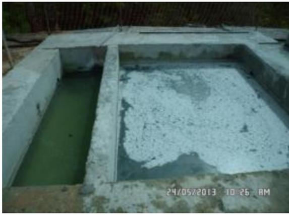
**Figura - 13 – Caixa de decantação da central de concreto da margem direita no sitio Pimental**
