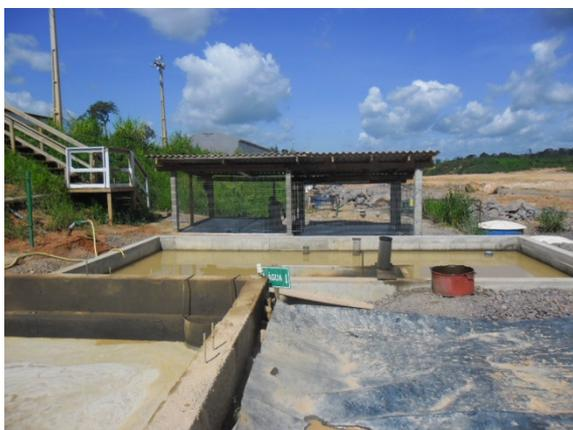
**Figura - 5 – Caixa de decantação - Sítio Canais e Diques**
