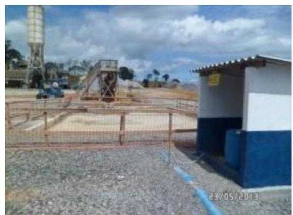
**Figura - 11 – Caixa de decantação da central de concreto - Sítio Pimental**
