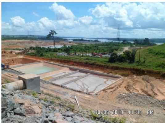
**Figura - 3 – Caixa de decantação - Central de Concreto definitiva - Sítio Belo Monte**
