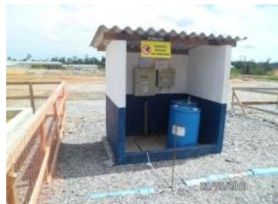
**Figura - 12 – Corretor de pH da central de concreto - Sítio Pimental**
