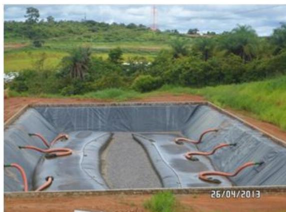
**Figura - 6 – Leito de secagem de lodo da ETA 100m<sup>3</sup>/h - Sítio Belo Monte**
