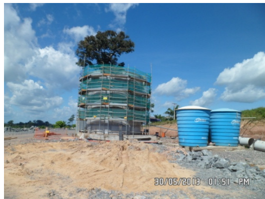
Figura - 8 – Construção dos Reservatórios apoiados de água tratada do Sítio Belo Monte
