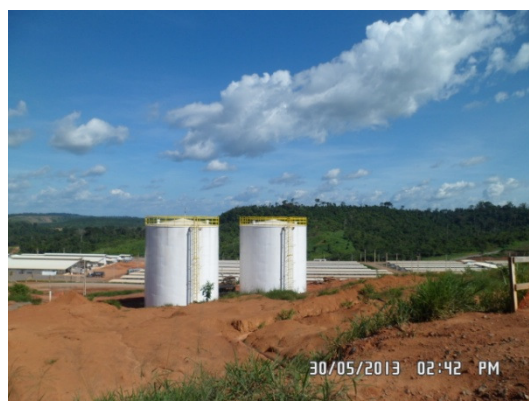
Figura - 6 – Construção dos Reservatórios apoiados de água tratada do Sitio Belo Monte
