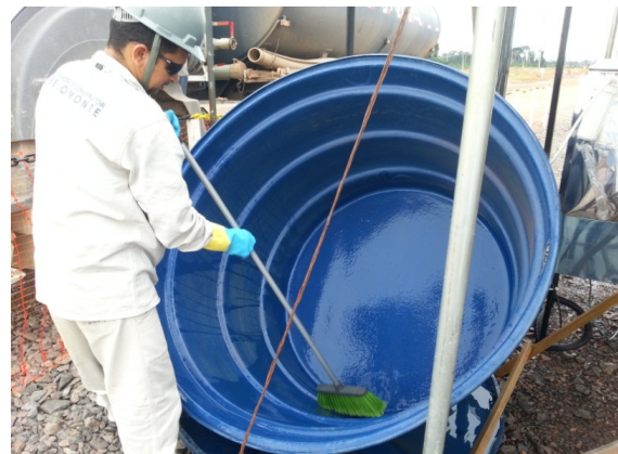
Figura - 20 – Limpeza nas caixas reservatório
