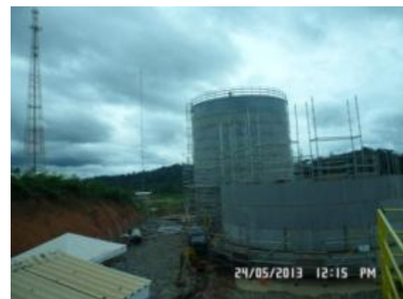
Figura - 24 – Construção dos Reservatórios apoiados de água tratada do Sitio Pimental
