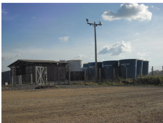
Figura - 15 – Estação de Tratamento de água Bela Vista
