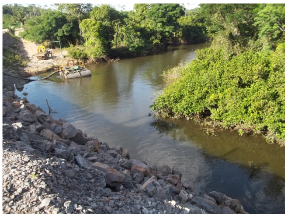
Figura - 11 – Captação de água bruta - Canais
