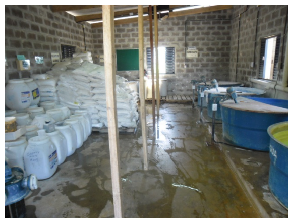
Figura - 16 – Depósito de produtos químicos ETA Canais
