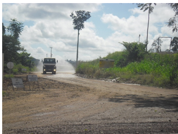
Figura - 11 – Umectação de vias no canteiro de Canais
