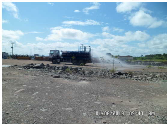
Figura - 7 – Umectação de vias no canteiro Belo Monte
