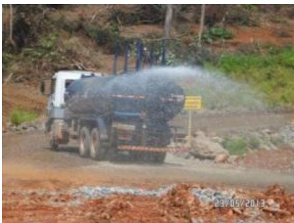
Figura - 9 – Umectação de vias no canteiro de Pimental
