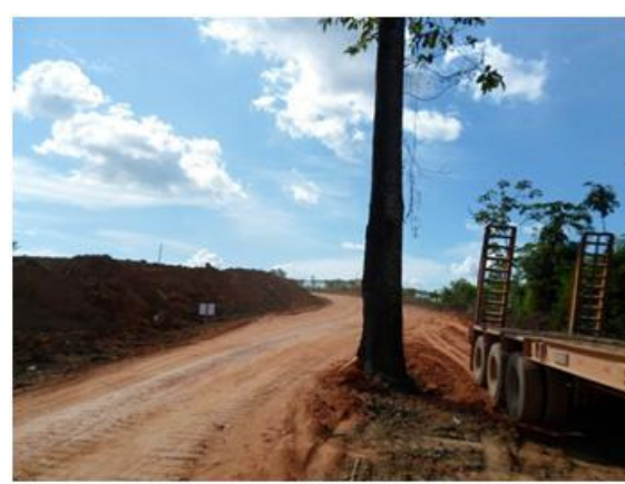
Figura - 12 – Acesso ao Dique 6 no Sítio Belo Monte
