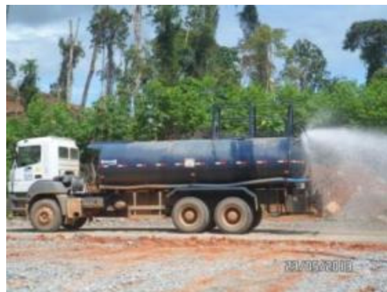
Figura - 10 – Umectação de vias no canteiro de Pimental
