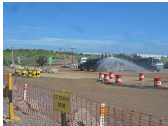
Figura - 8 – Umectação de vias no canteiro Belo Monte
