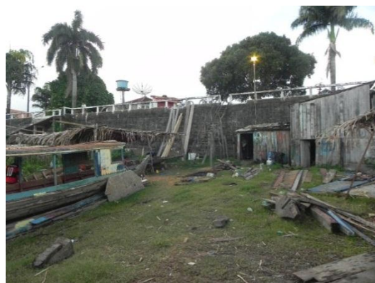
Figura 14.2.4 - 3 – Estaleiro próximo ao Porto 6 (Porto da Balsa) - local inundado durante a cheia do rio Xingu
