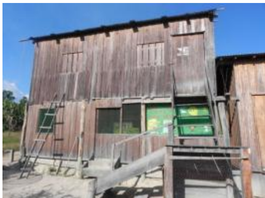
Figura 14.2.3 - 47 – EMEF Bacajai, na localidade do Rio / Gleba Bacajai – edificação em madeira.
