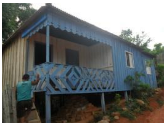
Figura 14.2.3 - 10 – Residência com estrutura em madeira e cobertura de amianto na área urbana (Belo Monte), janeiro/2013.
