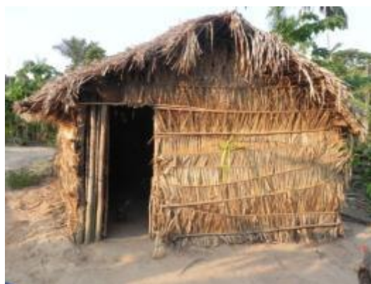
Figura 14.2.3 - 11 – Residência com estrutura e cobertura em palha na área rural (Rio das Pedras), janeiro/2013.
