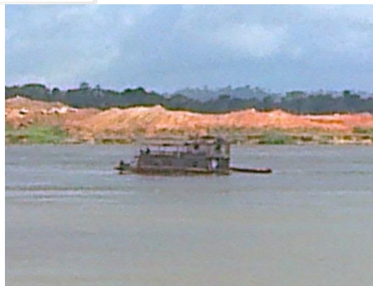
Figura 14.2.2 - 23 – Balsa passando pelo canal remanescente do rio Xingu, próximo ao barramento principal. Prestação de serviços na construção da UHE Belo Monte - Subgrupo 4. Janeiro/2013
