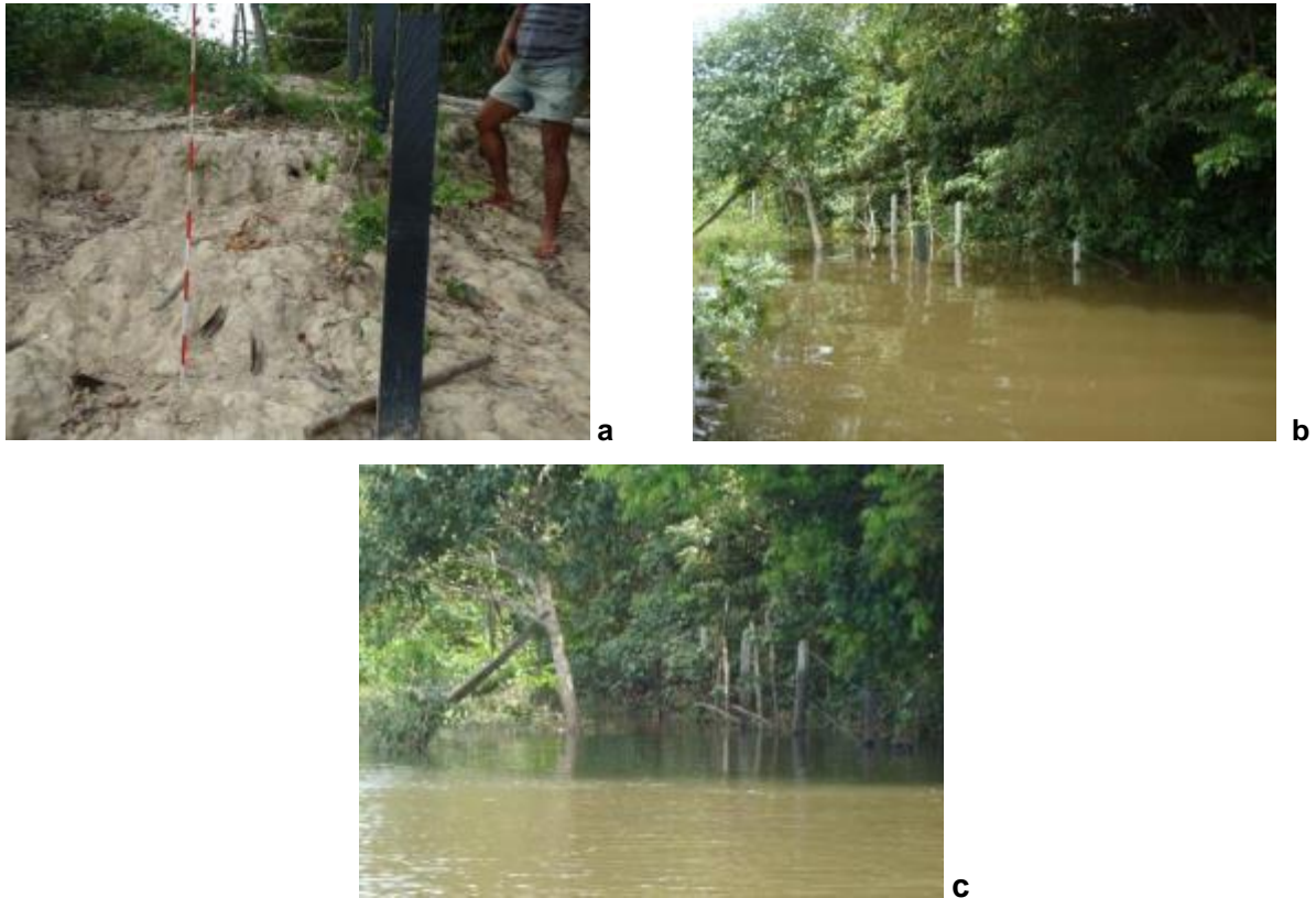
Figura 10.3 - 2 – Ponto R10 (coordenadas UTM 391985/9624116), local de instalação de monitor vertical. a) Inspeção realizada em novembro/2012; b) Inspeção realizada em fevereiro/2013; c) Inspeção realizada em maio/2013.
