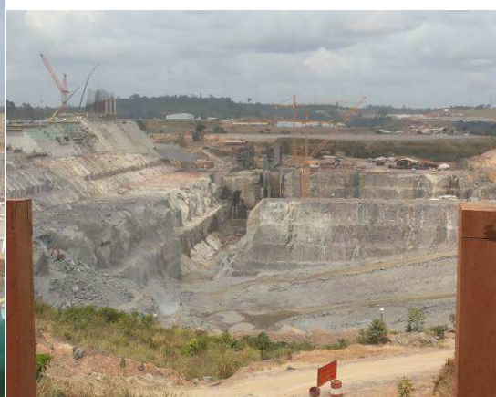
Figura 8 - Obras do Sítio Belo Monte.
