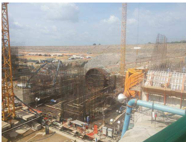
Figura 7 - Construção da casa de Força do sítio Pimental.
