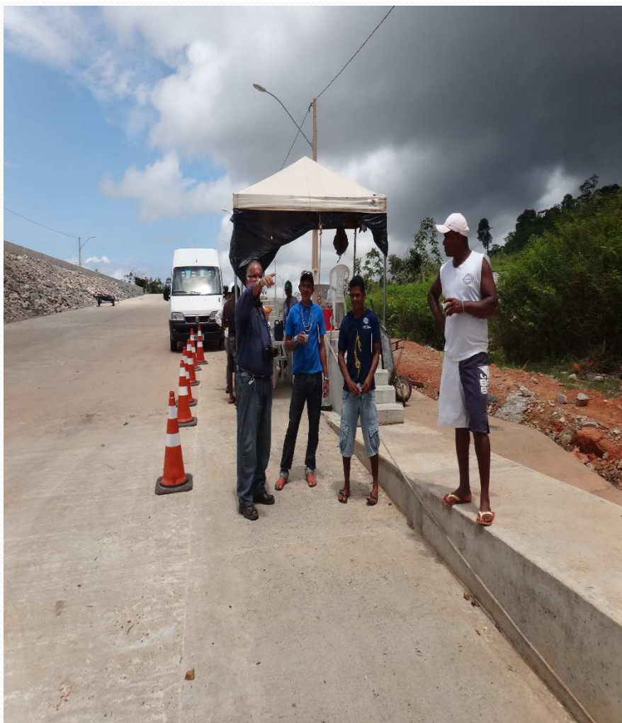
Rampa de acesso das embarcações de pequeno porte.
