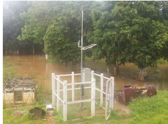
Figura 2: Estação de Monitoramento do Igarapé Panelas.
