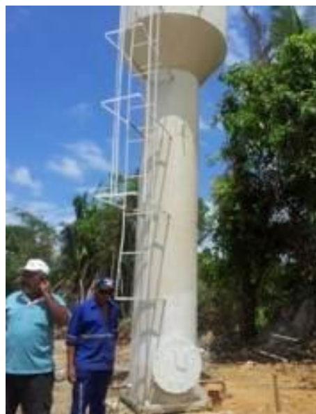
Figura 13.2 – 65 - Poço Ilha da Fazenda.
