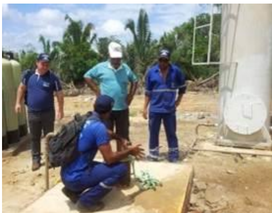
Figura 13.2 - 66 – Poço Ilha da Fazenda
