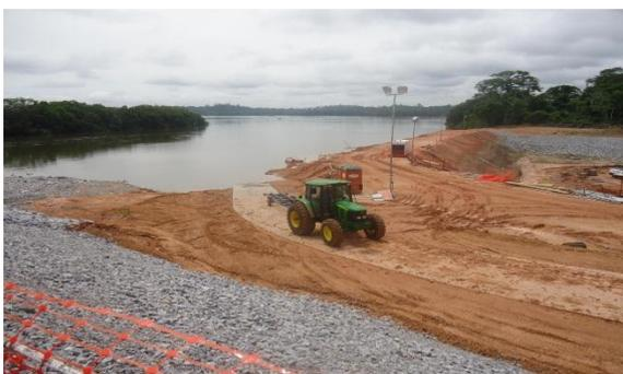
**Figura 14.2.1 – 3 - Carreta para o transporte de pequenas embarcações já disponível nas instalações em obras do STE**
