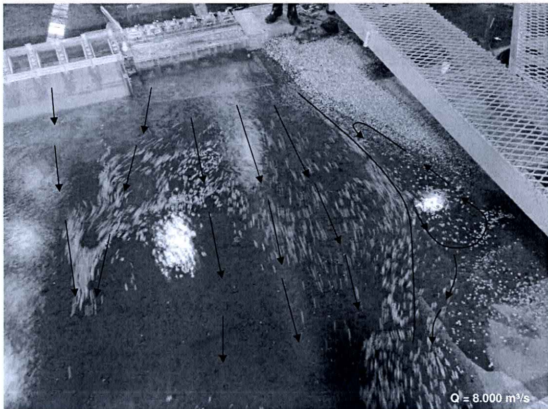
Figura 11 – Alternativa Final – Q = 8.000 m 3 /s – Configuração do escoamento a jusante da Casa de Força Complementar
