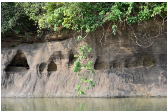
Figura 12.5 - 15 – Feições tipo piping nos arenitos do paredão entre os abrigos do Assurini e Abutre.
