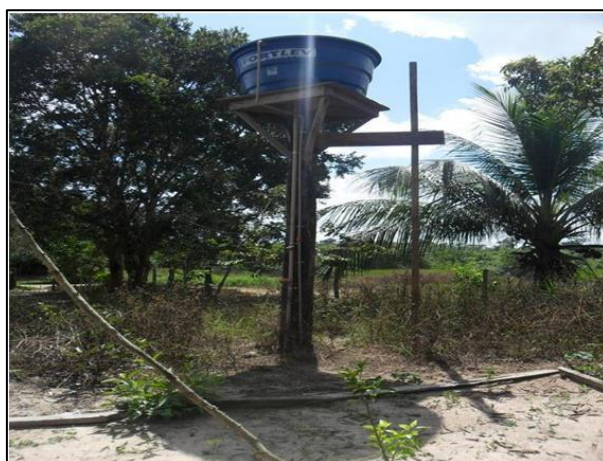
Figura 11.2 - 60 - Caixa d'água da residência da Sra. Maria Rosa
