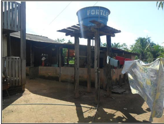
Figura 11.2 - 64 - Detalhe da Caixa D'água que abastece as duas residências
