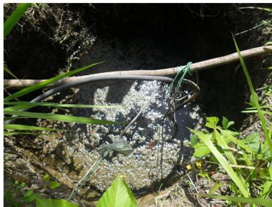
Figura 11.2 - 59 - Cacimba com bomba submersa do Sr. Nelson em meio ao pasto e a céu aberto
