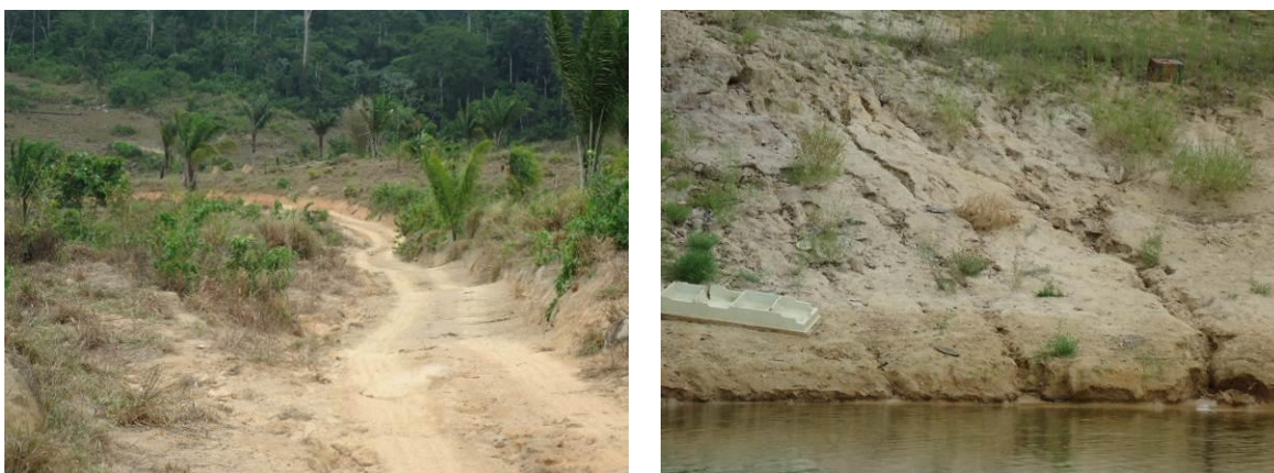
Figura 10.3 - 5 – Exemplos de processos erosivos lineares condicionados à presença de via de acesso e taludes desmatados nos quais há concentração de escoamento pluvial
