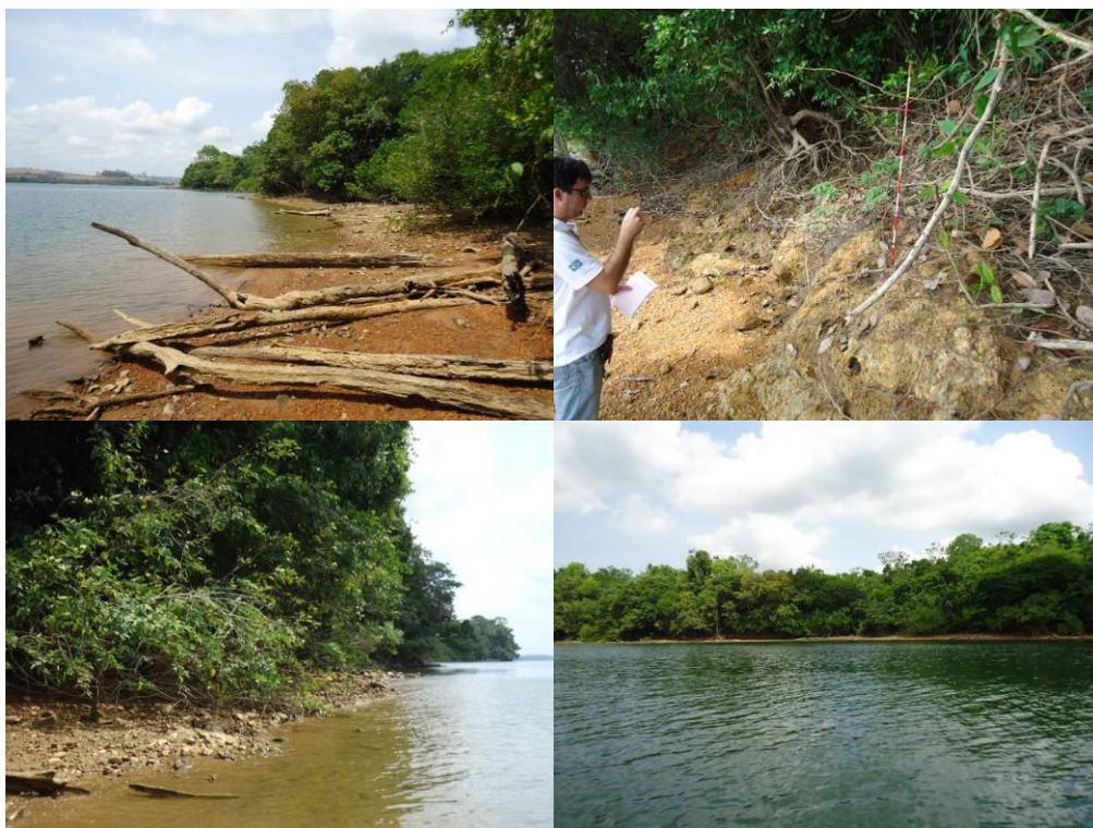
Figura 10.3 - 8 – Ilustrações da região em frente ao Canal de Fuga, sujeita à erosão. Neste local foi instalado o Marco de Monitoramento 2. Região a ser tratada preventivamente à erosão por efeito de ondas. Coordenadas 413.523 / 9.657.292.
