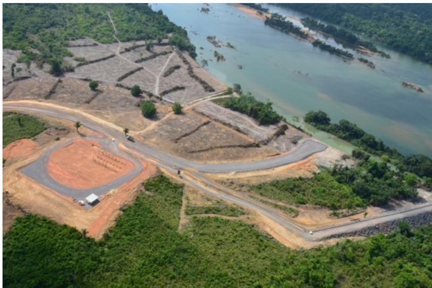
Canal de Derivação - Estaca 0 - Início do Canal
