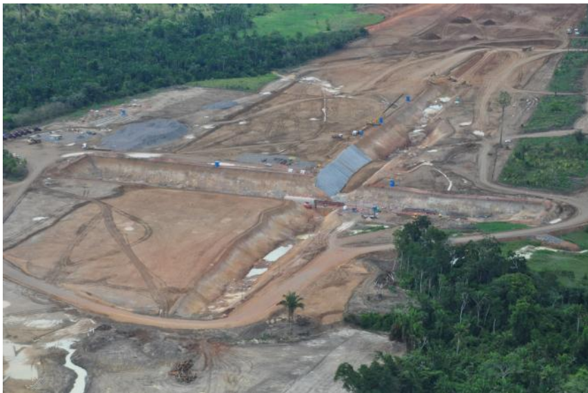
Detalhe - Dique 19B
