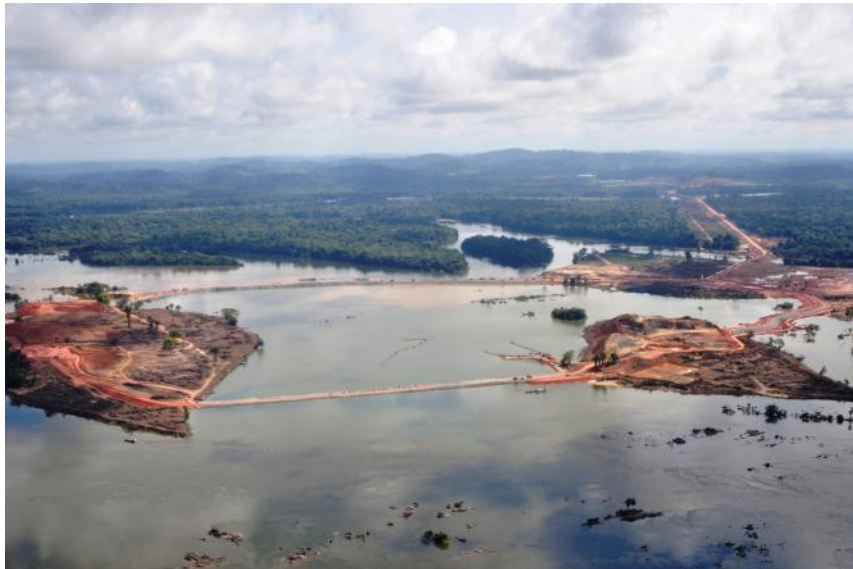
Sítio Pimental - Vista de jusante da Pré-ensecadeira do Canal Central
