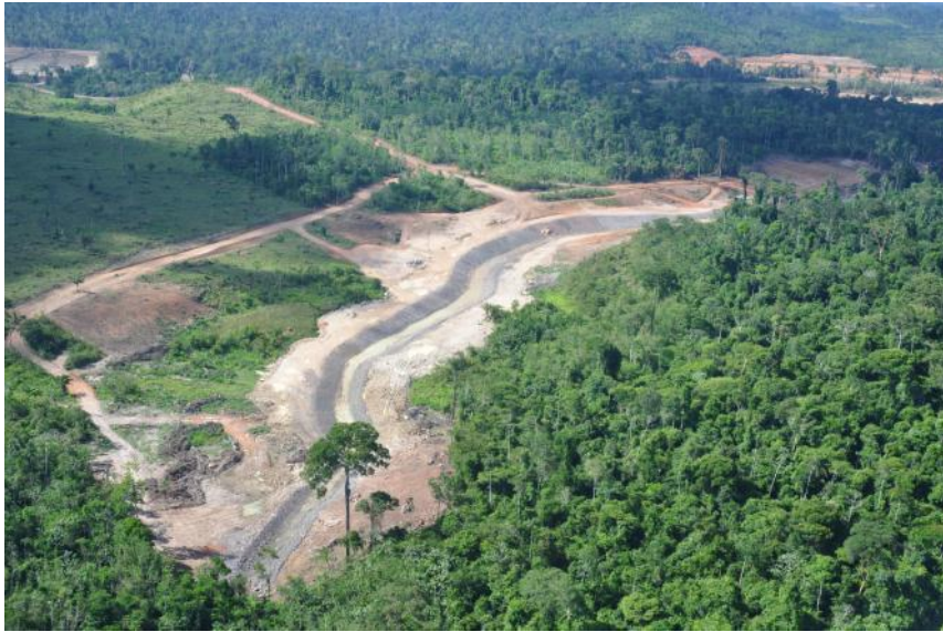
Canal de Derivação – Vista Parcial do Canal de Drenagem do Sistema Ticaruca
