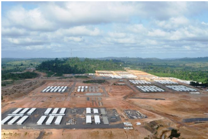
Canal de Derivação - Vista Geral do Canteiro Definitivo
