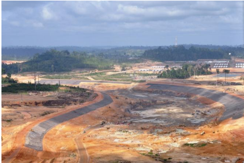
Canal de Derivação - Vista Geral
