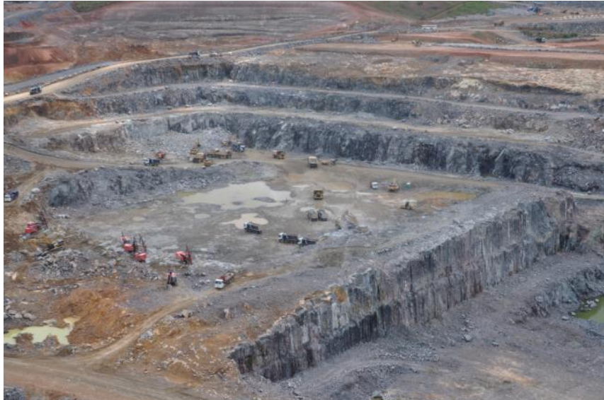
Sítio Belo Monte - Vista Geral das escavações das estruturas – Unidades 01 a 08
