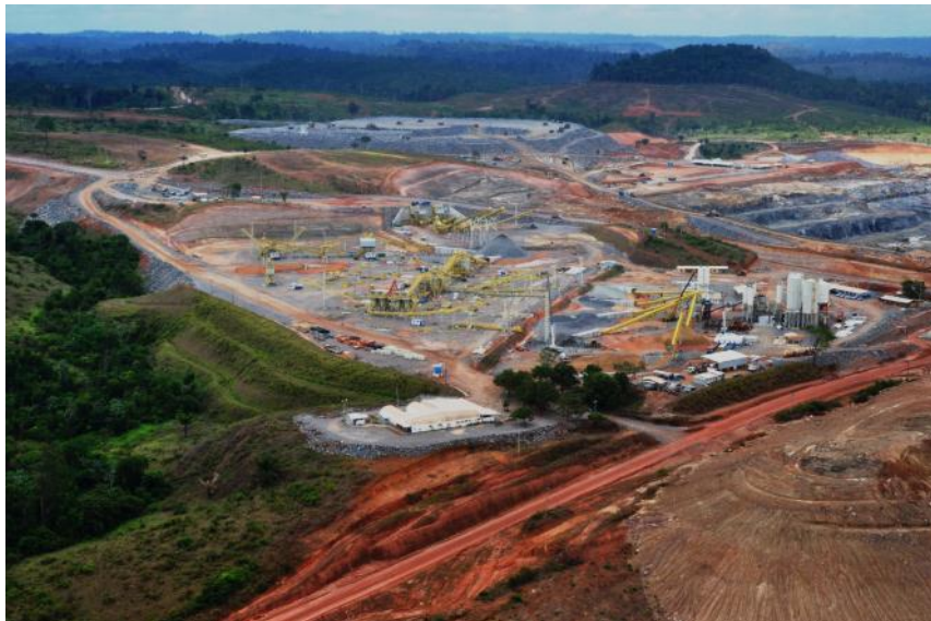
Sítio Belo Monte - Canteiro Industrial
