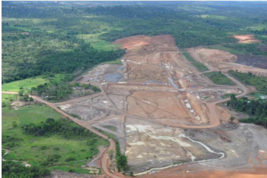
Reservatório Intermediário - Dique 19B
