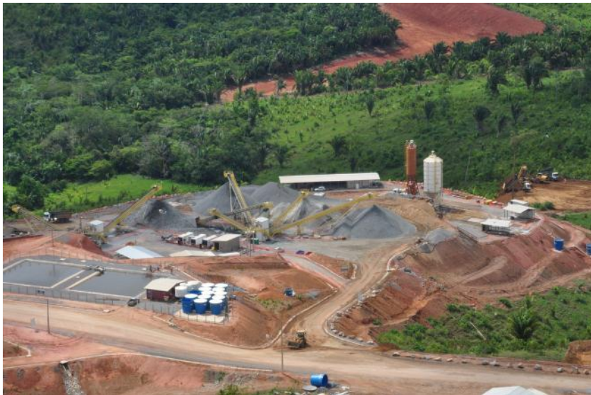
Canteiro Bela Vista - Canteiro Industrial
