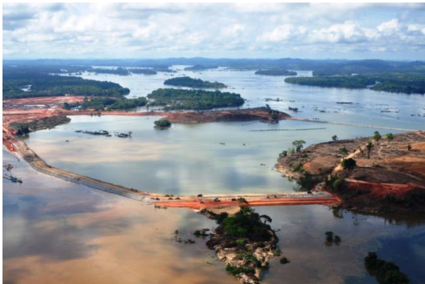
Sítio Pimental - Vista de montante da Pré-ensecadeira do Canal Central
