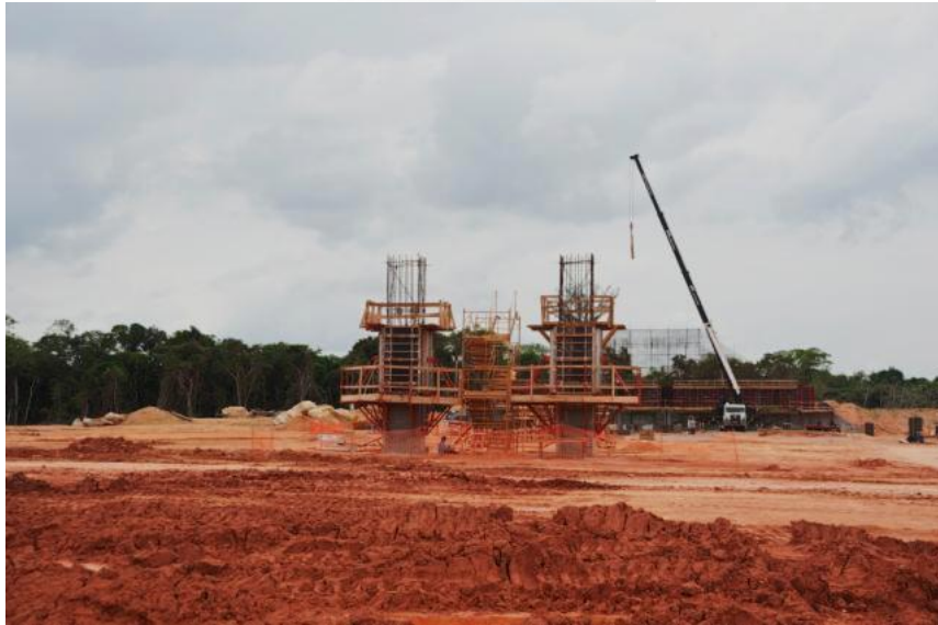
Sítio Pimental – Ilha Marciana - Canteiro Industrial
