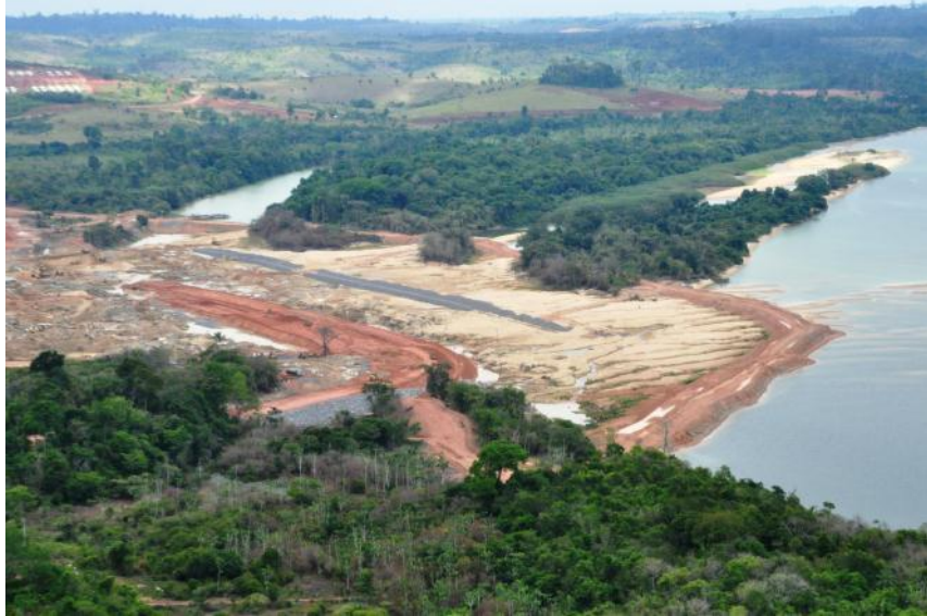
Sítio Belo Monte – Ensecadeira 2ª Fase a Jusante do Canal de Fuga
