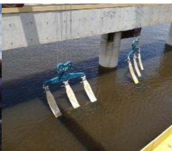
Foto 6: Operação das cintas de elevação das embarcações de grande porte.
