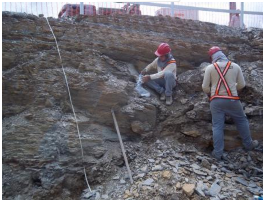
Figura 25 - Talude de rocha do ponto C3P4, descrito na coluna 4.
