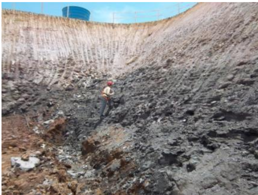
Figura 19 - Talude de rocha do ponto C2P2, descrito na coluna 2.
