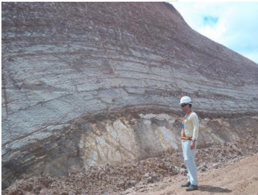
Figura 33 - Corte em via de acesso no Sítio Belo Monte – Área 1, onde as rochas da Formação Pitinga assentam-se diretamente sobre o embasamento.
