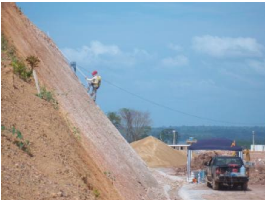
Figura 23 - Talude de rocha do ponto C3P2, descrito na coluna 2.
