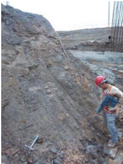
Figura 24 - Talude de rocha do ponto C3P3, descrito na coluna 3.
