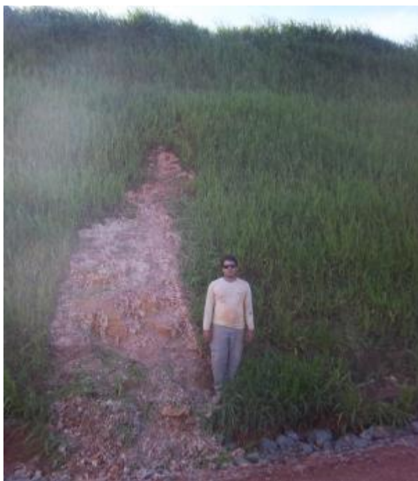
Figura 31 - Corte na margem oeste do Travessão 27 – Área 3.
