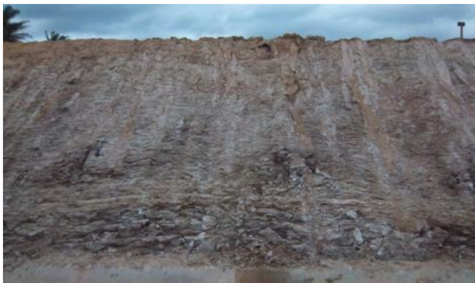
Figura 18 - Talude de rocha do ponto C2P1, descrito na coluna 1.
