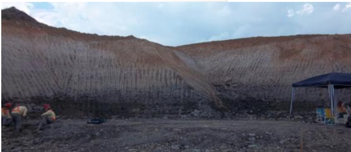
Figura 20 - Talude de rocha do ponto C2P3, descrito na coluna 3.
