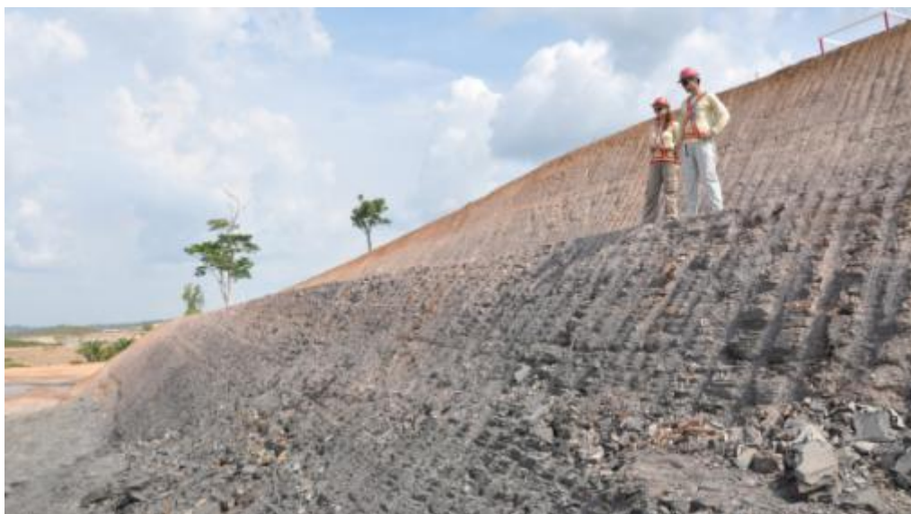
Figura 21 - Talude de rocha do ponto C2P4, descrito na coluna 4.
