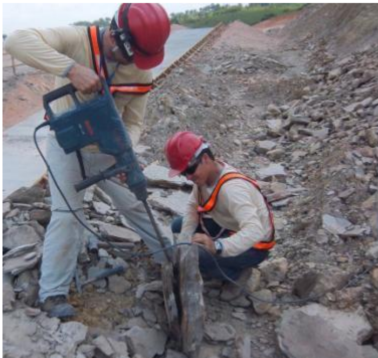
Figura 4 - Uso do martelo demolidor na busca por macrofósseis em camadas de rocha sedimentar.
