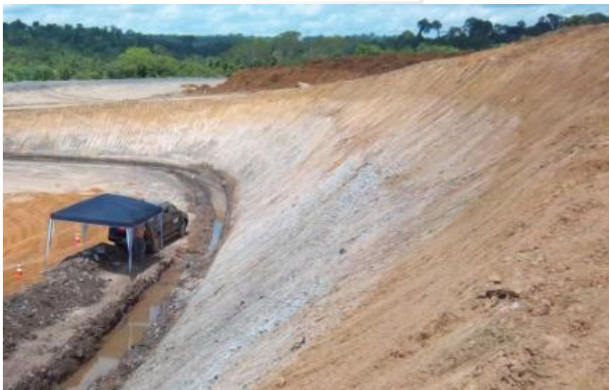
Figura 15 - Talude de rocha do ponto C1P3, descrito na coluna 2.
