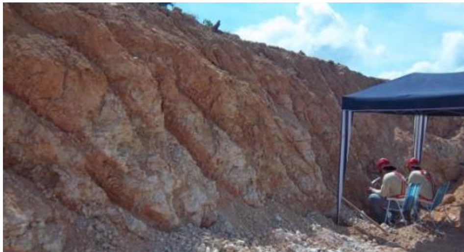
Figura 17 - Talude de rocha do ponto C1P6, descrito na coluna 4.
