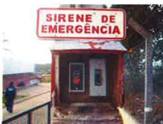
Utilizado no veículo da segurança e nos canteiros para emitir sinais sonoros perceptíveis à todos do canteiro, alertando quanto às situações e emergência que necessitem evacuação de área.
