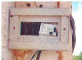
Utilizado para detectar fuga de corrente em circuitos elétricos desligando imediatamente a alimentação de corrente elétrica. As fugas de corrente não são visíveis e normalmente ocorrem por deficiência da isolação dos fios ou por toques involuntários de pessoas em pontos eletrificados.
