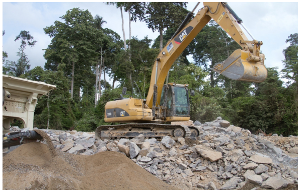
Treino Operação de Escavadeira
