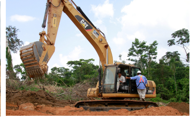
Treino Operação de Escavadeira
