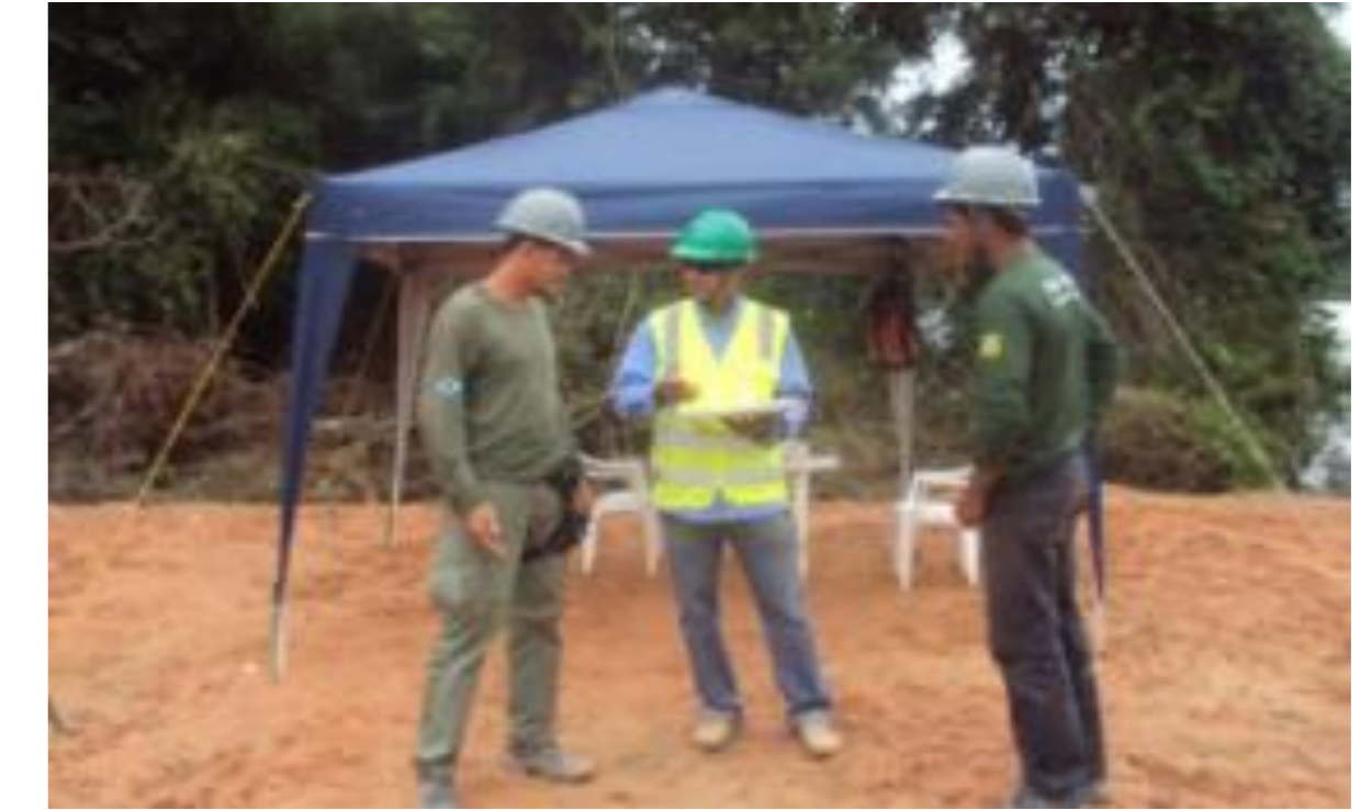
Treinamento com sinaleiros (terraplanagem)
