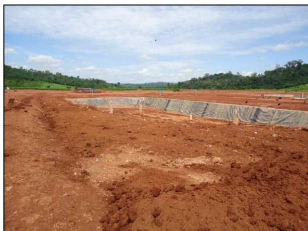
Figura 3.1 - 65 – Operação da vala 01 do Aterro sanitário do Sítio Belo Monte
