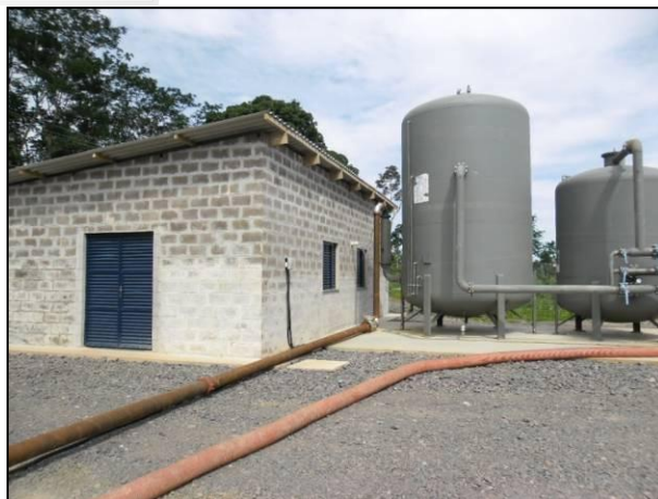
Figura 3.1 - 46 - Instalação da ETA Sítio Canais e Diques com capacidade de 100 m 3 /hora
