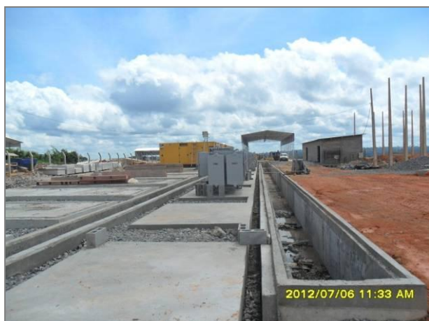
Figura 3.1 - 21 – Subestação sendo construída no Sítio Belo Monte
