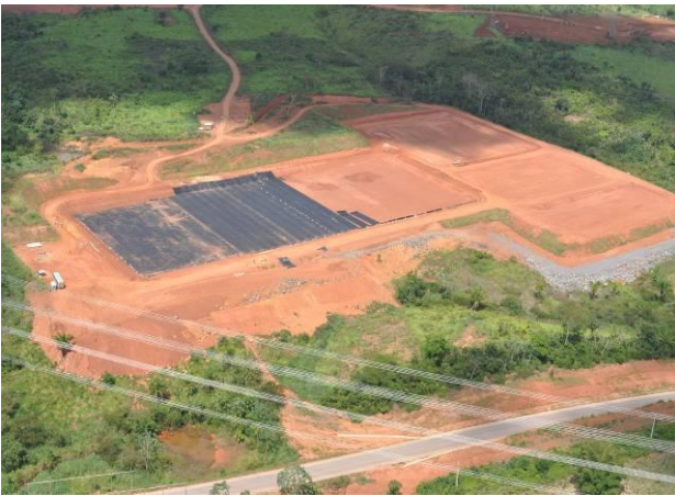
Figura 3.1 - 55 - Terraplanagens das lagoas definitivas do Sítio Belo Monte
