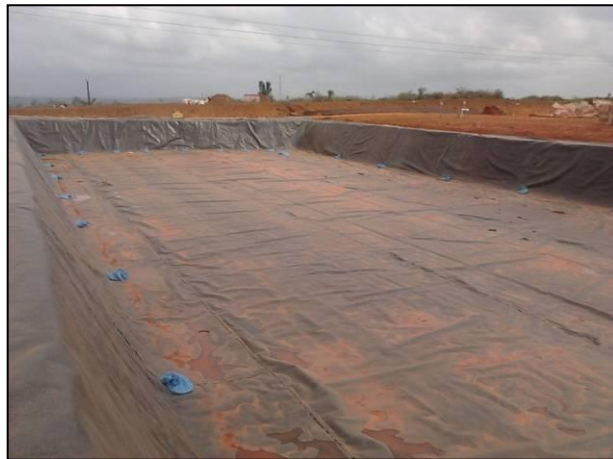
Figura 3.1 - 63 – Impermeabilização da vala do Aterro sanitário do Sítio Belo Monte
