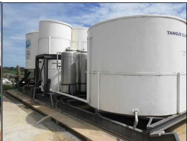
Figura 3.1 - 44 - ETA Sítio Canais e Diques com capacidade de 20 m 3 /hora
