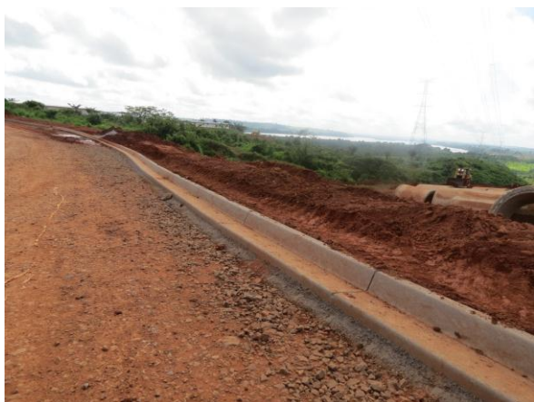
Figura 3.1 - 19 – Canaletas do Canteiro Definitivo do Sítio Belo Monte
