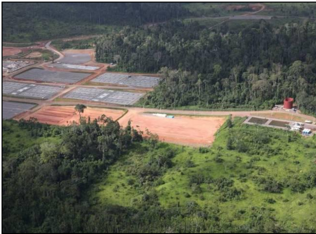
Figura 3.1 - 11 – Canteiro Definitivo do Canal
