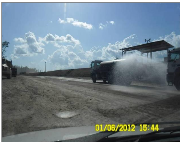
Figura 3.1 - 7 – Umectação das vias de acesso
