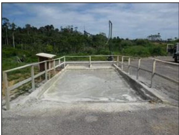
Figura 3.1 - 61 - Caixa decantadora de concreto do Sítio Canais e Diques
