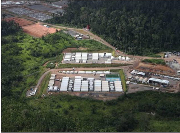
Figura 3.1 - 9 – Canteiro Pioneiro do Canal
