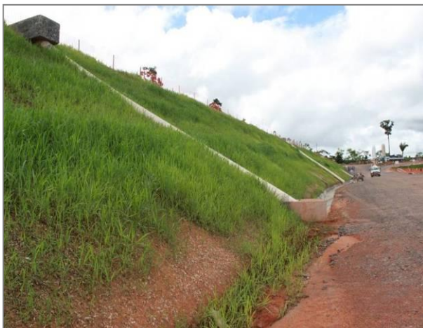
Figura 3.1 - 17 – Canteiro Definitivo do Canal
