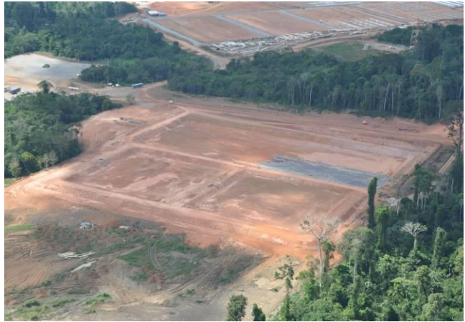
Figura 3.1 - 56 - Terraplanagens das lagoas definitivas dos Sítios Pimental
