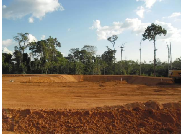
Figura 3.1 - 68 - Escavação das valas do aterro sanitário do Sítio Pimental
