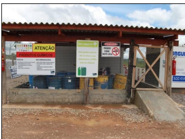
Figura 3.1 - 36 - Deposito de produtos químicos do Sítio Canais e Diques
