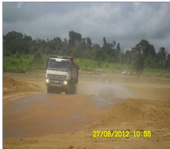
Figura 3.1 - 8 - Umectação das vias de acesso
