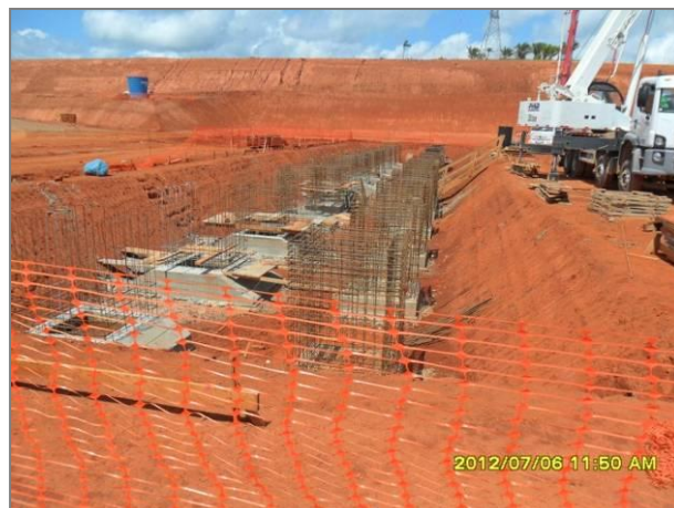
Figura 3.1 - 22 – Subestações sendo construídas no Sítio Belo Monte
