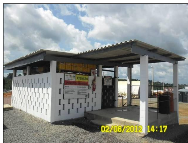
Figura 3.1 - 37 - Deposito de produtos químicos do Sítio Canais e Diques
