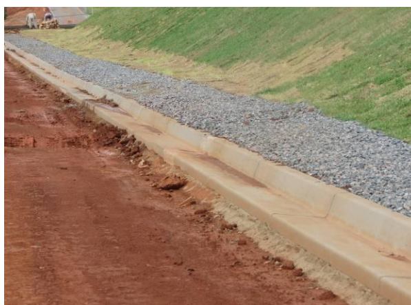
Figura 3.1 - 20 – Canaletas do Canteiro Definitivo do Sítio Canal e Diques
