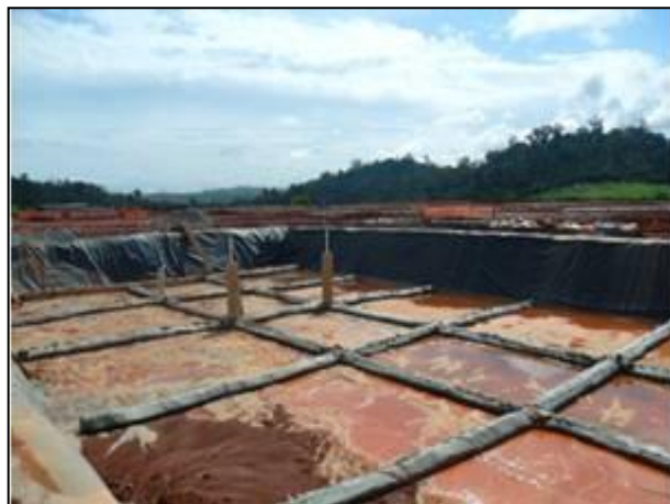
Figura 3.1 - 64 – Construção dos drenos de chorume das valas do Aterro sanitário do Sítio Belo Monte
