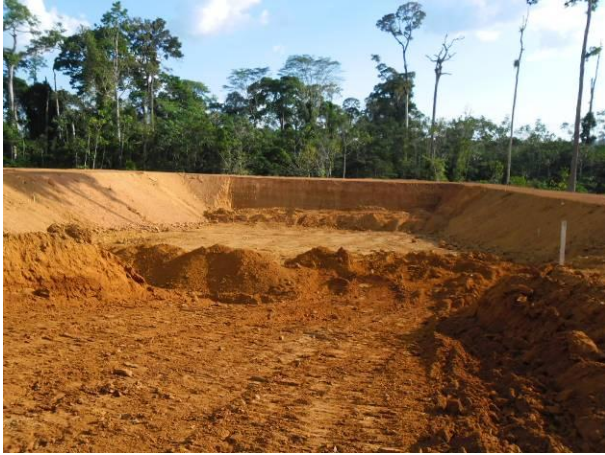
Figura 3.1 - 67 – Escavação das valas do aterro sanitário do Sítio Pimental
