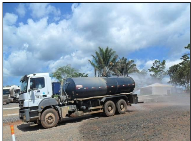
Figura 3.1 - 28 - Umectação das vias de acesso.
