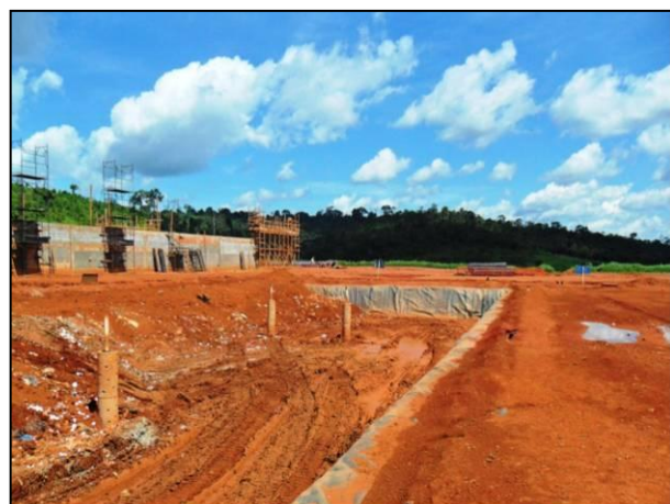
Figura 3.1 - 66 – Operação da vala 02 do Aterro sanitário do Sítio Belo Monte
