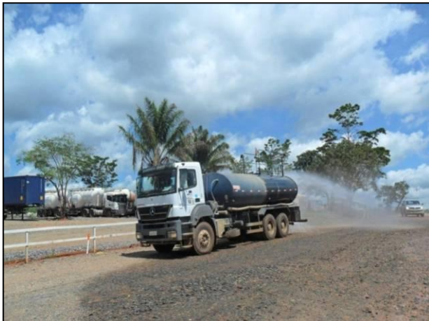
Figura 3.1 - 27 - Umectação das vias de acesso
