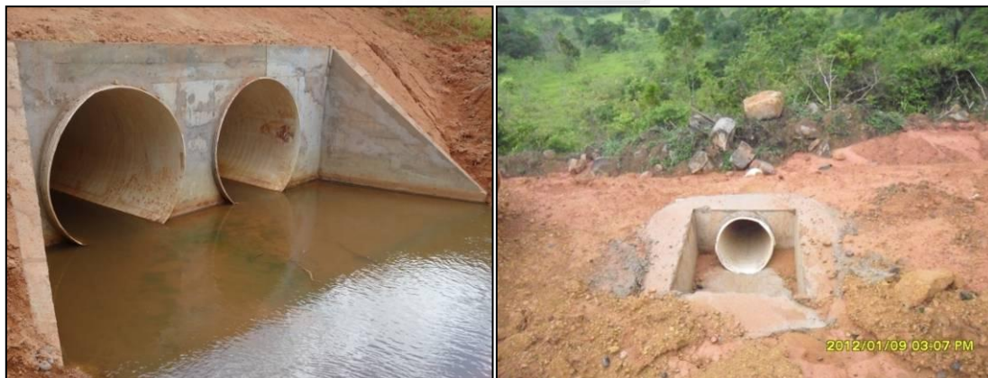
Figura 3.1 - 1 e 3.1 - 2 – Exemplos da aplicação de Ribloc'S
