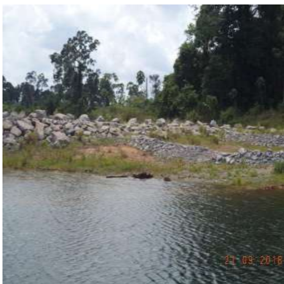
Figura 3: Ponto com potencial de acesso ao RI, encontrado no Ponto 2.
