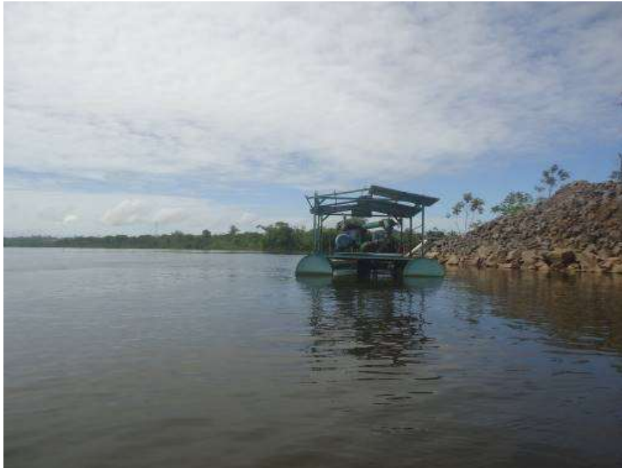
Foto - 1 – Vista do ponto CAPTAÇÃO BELO MONTE na campanha de maio de 2019
