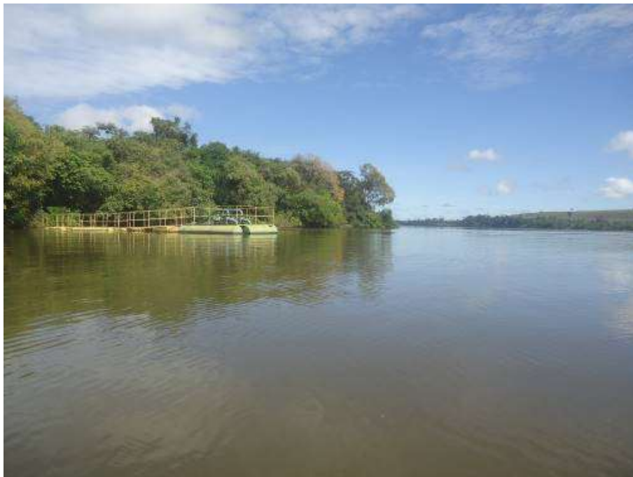
Foto - 1 – Vista geral do ponto de monitoramento localizado a montante da Vila Residencial em maio de 2019
