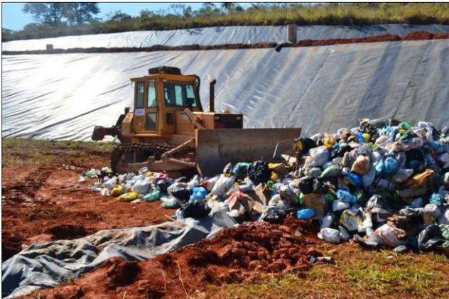
Na frente de operação, os resíduos devem ser espalhados e compactados por um equipamento apropriado (preferencialmente um trator de esteira com peso operacional mínimo de 15 toneladas) em rampas com inclinação aproximada de 1 na vertical para 3 na horizontal
