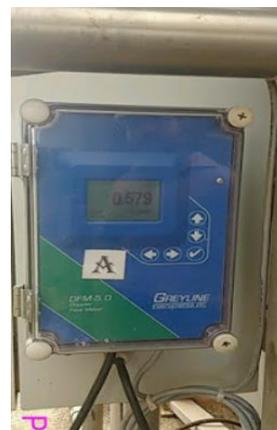
*Figura 16 - Medidor de Vazão Ultrassônico ETE Altamira*
