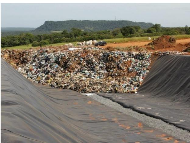
Local destinado ao aterramento dos resíduos, previamente preparado, em conformidade com as normas técnicas e ambientais vigentes, com adoção de sistemas de impermeabilização de base e das laterais e de drenagens de chorume, de águas pluviais e de gases.
