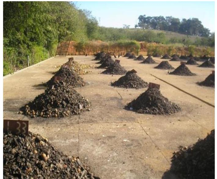
Uma usina de triagem e compostagem de lixo são constituídas basicamente de unidades de apoio; unidade de recepção dos resíduos; unidade de triagem; pátio de compostagem; baias ou galpões para armazenamento de recicláveis e do composto curado, além da área de aterramento dos rejeitos. O que não pode ser aproveitado é aterrado em valas de rejeitos.
