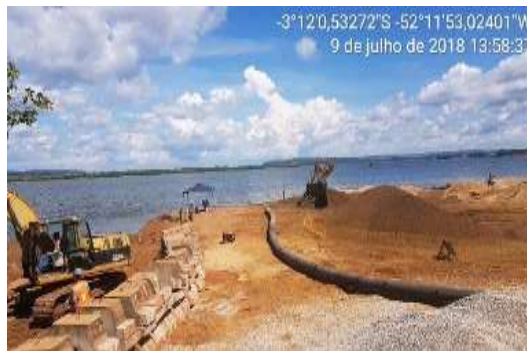
Figura 5.1.9-12 – Reparos/ desobstruções no emissário da ETE
