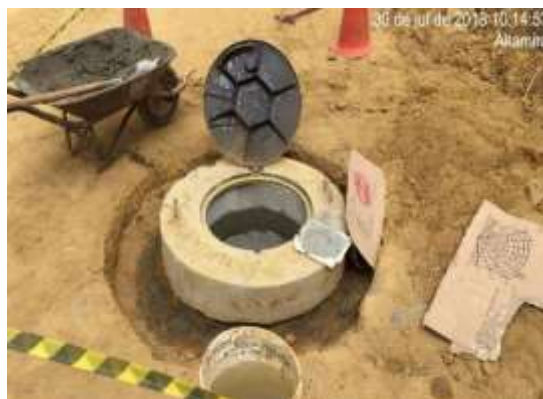
Figura 5.1.9-20 – Serviços de reparo e manutenção da rede
