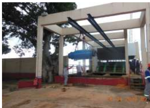
Figura 5.1.9-26 – Manutenção corretiva das bombas da captação de água bruta
