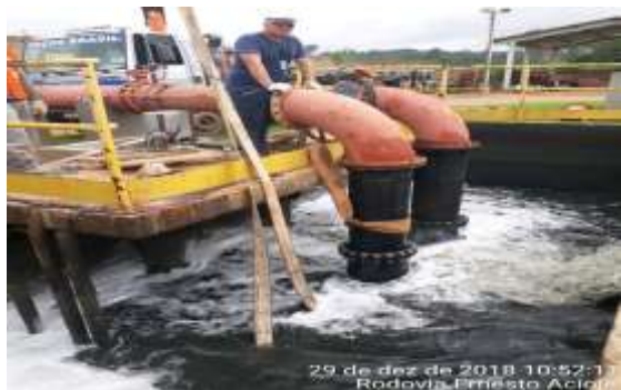
Figura 5.1.9-11 – Substituição da Bomba da ETE
