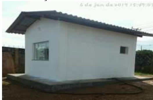
Figura 5.1.9-14 – Guarita da ETE
