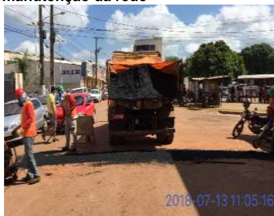
Figura 5.1.9-22 – Pavimentação asfáltica após obras de manutenção corretiva de Rede Coletora de Esgoto
