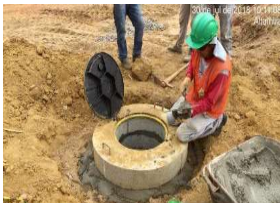
Figura 5.1.9-19 – Serviços de reparo e manutenção da rede
