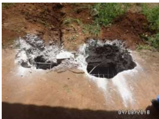
Figura 5.1.9 - 9 – Limpeza e desinfecção de fossa séptica e Figura 5.1.9 - 10 – Recomposição do Piso após desinfecção de fossa
