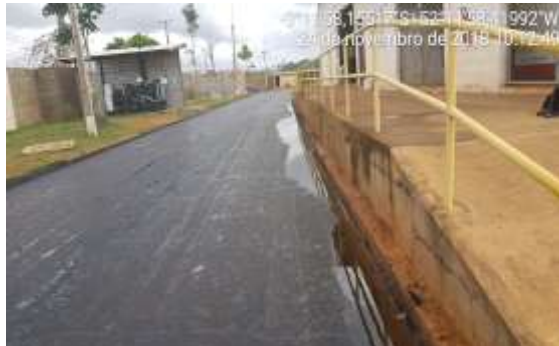
Figura 5.1.9-13 – Pavimentação Asfáltica no interior da ETE
