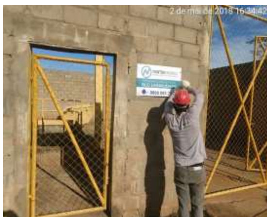
Figura 5.1.9-17 – Instalação de placas de sinalização na E.E.E do RUC Laranjeiras
