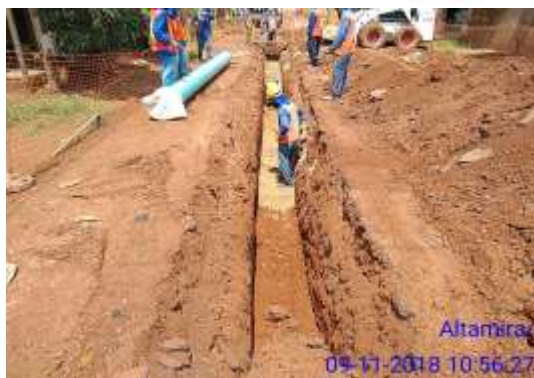
Figura 5.1.9-25 – Execução de adutora de água bruta Ø300
