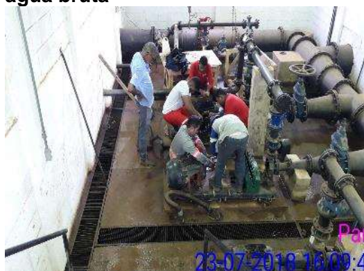
Figura 5.1.9-28 – Montagem do motor no RAP Ibiza
