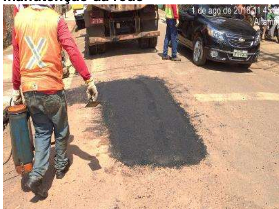
Figura 5.1.9-21 – Pavimentação asfáltica após obras de manutenção corretiva de Rede Coletora de Esgoto
