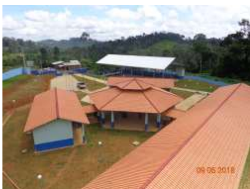
Figura 4.8.1-1 – Vista aérea da EMEF Santa Izabel.
