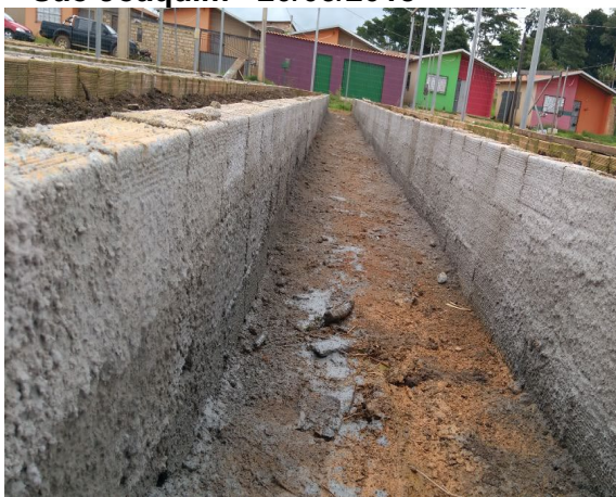
Figura 4.4.4 - 43 – Chapiscagem dos Canteiros – São Joaquim - 29/03/2018
