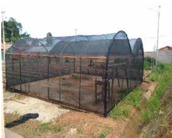
Figura 4.4.4 - 45 – Finalização da Cobertura do viveiro e da instalação da porta – São Joaquim – 04/05/2018
