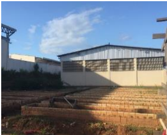
Figura 4.4.4 - 39 - Construção dos canteiros - UDAMA - São Joaquim - 18/01/2018
