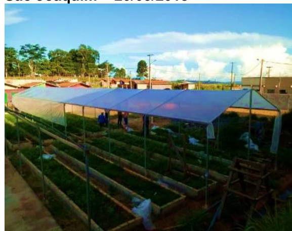
Figura 4.4.4 - 44 – Instalação do filme agrícola da estufa – UDAMA – São Joaquim – 19/04/2018
