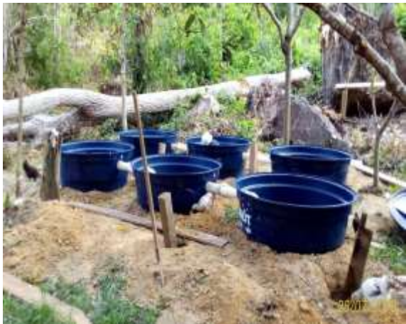
Figura 4.1.5. – 89 - Instalação de Fossas Sépticas Biodigestoras. Nivelamento das caixas – Ilha do Pedão. 28/07/2018
