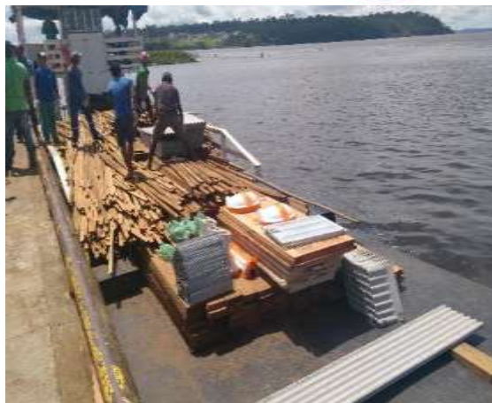
Figura 4.1.5. – 74 - – Mutirão para transporte do material necessário para a construção da escola provisória – Palhal - 05/05/2018
