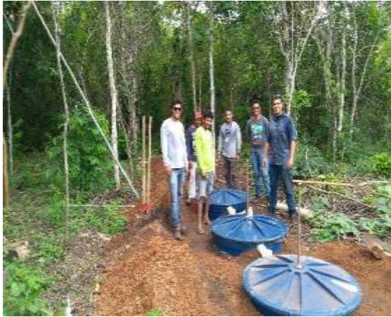
Figura 4.1.5. – 100 – Mutirão para Construção de Fossa Biodigestora - 15/02/2018
