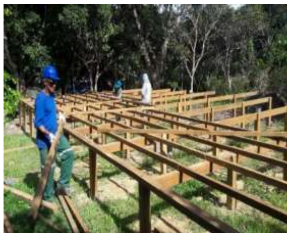
Figura 4.1.5. – 83 - Mutirão para construção da base do assoalho da escola provisória – Ilha do Pedão - 08/05/2018
