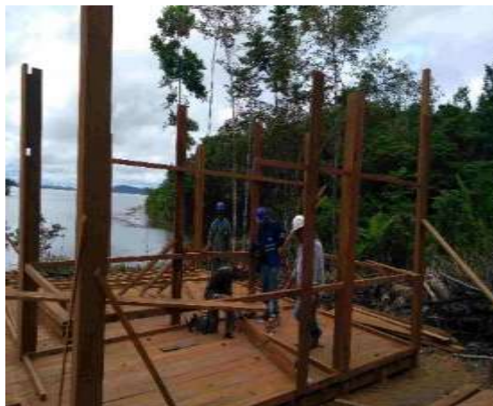
Figura 4.1.5. – 75 - Mutirão para finalização da construção do assoalho e início da construção das paredes da escola provisória – Palhal - 14/05/2018
