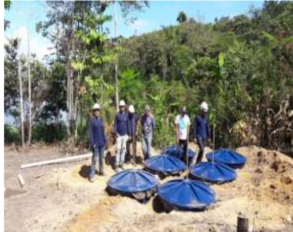
Figura 4.1.5. – 79 - Instalação de Fossas Sépticas Biodigestoras – Palhal. 27/07/2018
