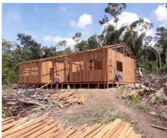
Figura 4.1.5. – 76 - Finalização da construção das paredes e início da construção do telhado da escola provisória – Palhal - 22/05/2018
