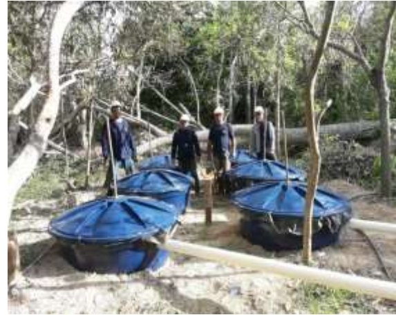
Figura 4.1.5. – 91 – Instalação de Fossas Sépticas Biodigestoras – Ilha do Pedão. 28/07/2018
