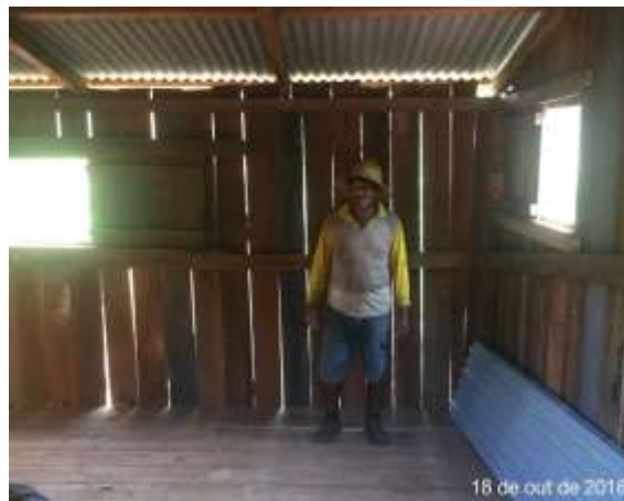
Figura 4.1.5 – 39 – Acompanhamento da Construção do Galpão – 18/10/2018
