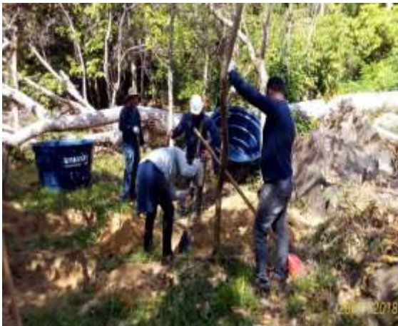
Figura 4.1.5. – 88 - Instalação de Fossas Sépticas Biodigestoras – abertura dos buracos – Ilha do Pedão. 28/07/2018
