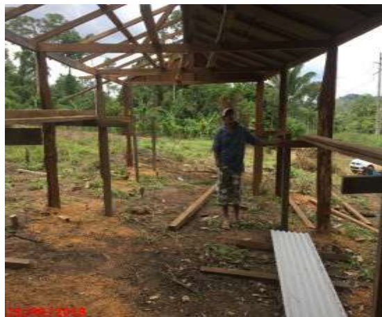
Figura 4.1.5 – 29 – Acompanhamento da construção e entrega de material – RAR - 23/09/2018
