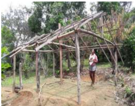
Figura 4.1.5. – 13 – Acompanhamento técnico da construção do aviário – Projeto de Criação de Galinhas – 13/03/2018
