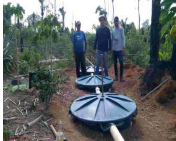
Figura 4.1.5. – 101 – Mutirão para Construção de Fossa Biodigestora - 14/09/2018
