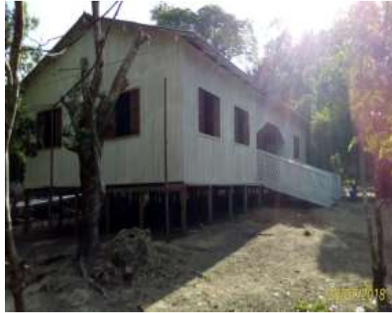
Figura 4.1.5. – 87 - Estagio da construção da escola provisória – Ilha do Pedão – 28/07/2018
