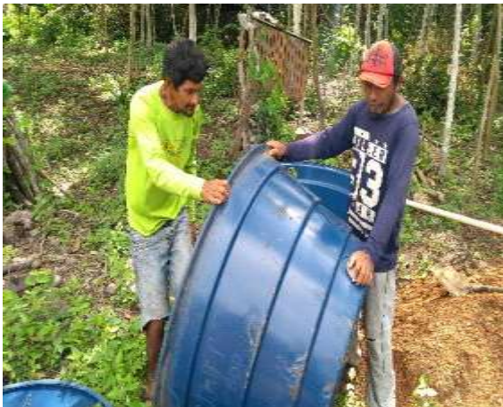
Figura 4.1.5. – 98 – Mutirão para Construção de Fossa Biodigestora - 15/02/2018
