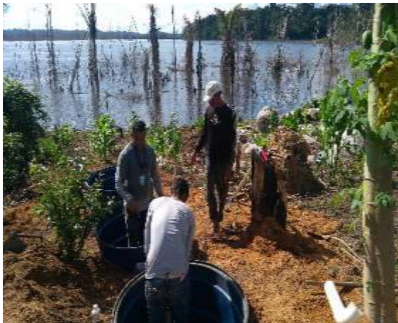
Figura 4.1.5. – 99 – Mutirão para Construção de Fossa Biodigestora - 15/02/2018
