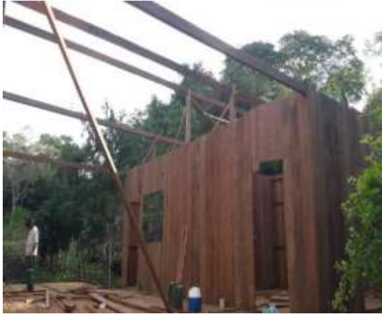
Figura 4.1.5. – 86 - Mutirão para construção do telhado da escola provisória – Ilha do Pedão - 15/05/2018
