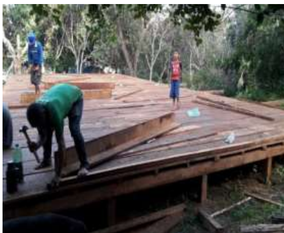
Figura 4.1.5. – 84 - Mutirão para finalização da base do assoalho da escola provisória e início da construção das paredes – Ilha do Pedão - 09/05/2018
