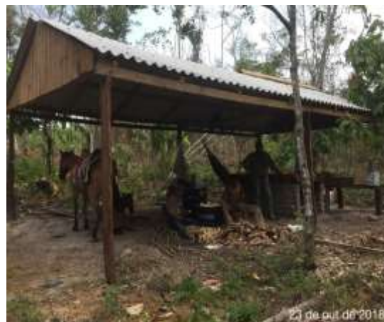
Figura 4.1.5 – 31– Estrutura da casa de farinha concluída–23/10/2018
