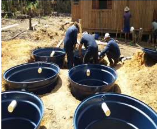
Figura 4.1.5. – 78 - Instalação de Fossas Sépticas Biodigestoras – nivelamento das caixas – Palhal. 27/07/2018
