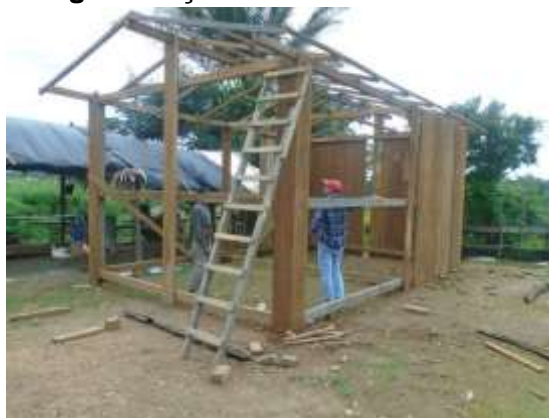
Figura 4.1.5 – 3 – Projeto de Benfeitorias e Estruturas – Construção de Galpão no RAR - 03/04/2018
