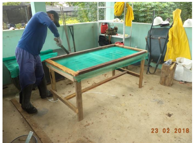
Figura 52: Construção da mesa de tela para a secagem das sementes.
