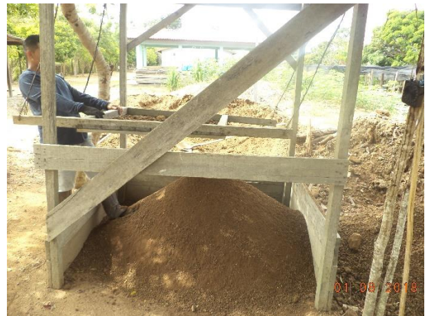
Figura 46: Preparo de solo.
