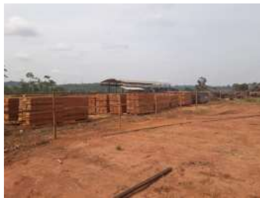
Figura 12.1.2 – 26 Cercas reformadas separando as serrarias
