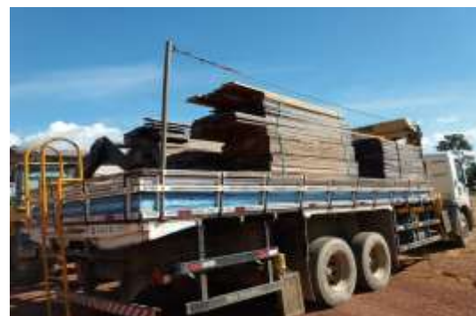
Figura 12.1.2 – 9 - Carregamento de caminhão com destino à montagem eletromecânica
