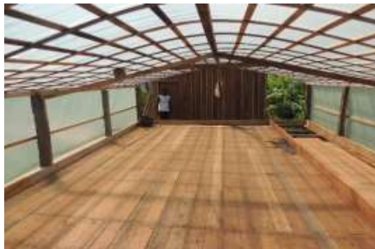
Figura 12.1.2 – 7 - Galpão para armazenamento de amêndoas conjugado com a estufa
