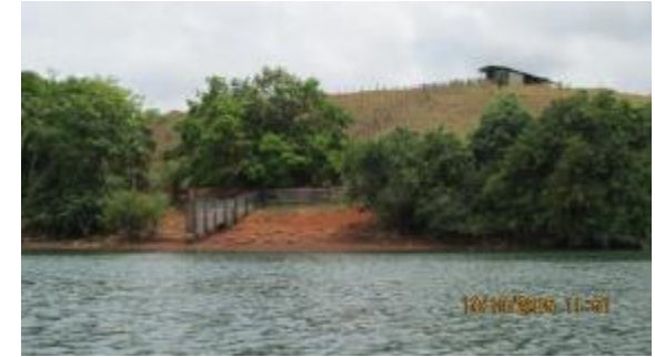
Inspeção Trimestral 15 (outubro/2015 - seca): Área aparentemente estável. Maior exposição do talude devido ao rebaixamento da lâmina de água.
