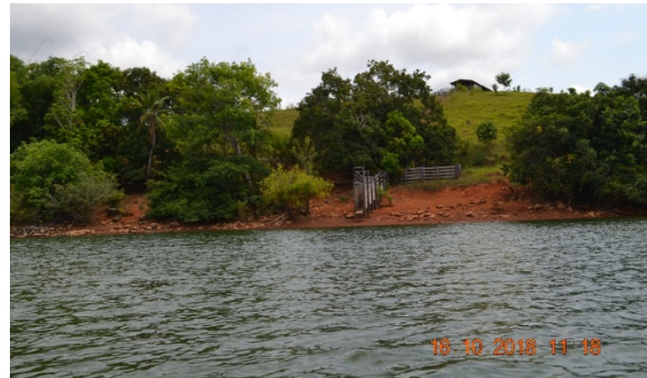
Inspeção trimestral 29 (outubro/2018 - seca): Zona de praia e talude mais expostos devido ao período de seca. Verifica-se que não há ocorrência de processos erosivos e instabilizatórios na encosta monitorada.
