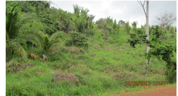
Inspeção 18 (fevereiro/2016 - enchente): Área estável com base na conformação existente
