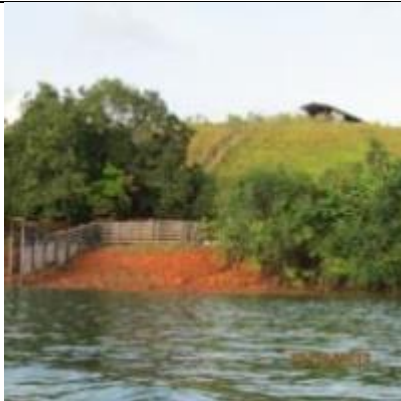
Inspeção Trimestral 7 (outubro/2013 - seca): Área aparentemente estável, sem mudança de risco geotécnico em relação aos valores originais.
