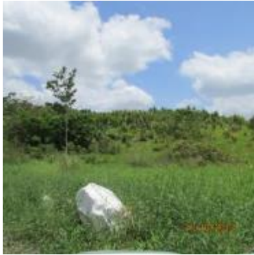
Inspeção Trimestral 7 (outubro/2013 - seca): Área aparentemente estável.
