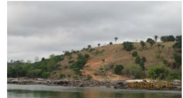
Inspeção Trimestral 15 (outubro/2015 - seca): Maior exposição dos blocos rochosos na base do talude e no leito do rio. Área aparentemente estável.
