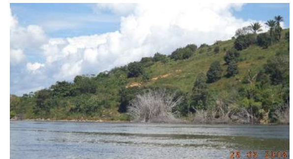
Inspeção trimestral 27 (maio/2018 - cheia): Blocos rochosos, na base e no leito do rio, parcialmente submersos devido ao período de enchente. Processo erosivo estável. Situação semelhante ao observado em janeiro de 2018.
