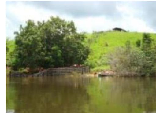
Inspeção Trimestral 9 (abril/2014 - cheia): Área aparentemente estável sob o ponto de vista geotécnico, observando-se ainda uma redução da exposição do talude, devido à elevação do nível do rio.
