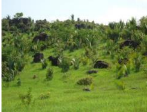
Inspeção Trimestral 2 (agosto/2012 - vazante): Encosta vegetada, com matações residuais de rocha cristalina, houve um aumento na densidade de vegetação.
