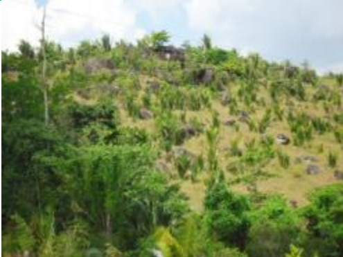
Inspeção Trimestral 1 (maio/2012 - cheia): Encosta vegetada, com matações residuais de rocha cristalina.
