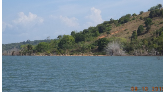
Inspeção trimestral 29 (outubro/2018 - seca): Blocos rochosos, na base e no leito do rio, mais expostos devido ao rebaixamento do nível de água. Situação geotécnica semelhante ao observado no mesmo período do ano de 2017.
