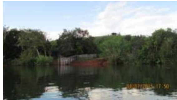
Inspeção Trimestral 14 (julho/2015 - vazante): Área aparentemente estável. Devido à diminuição do nível do rio, observa-se a exposição do talude, recoberto na vistoria anterior.
