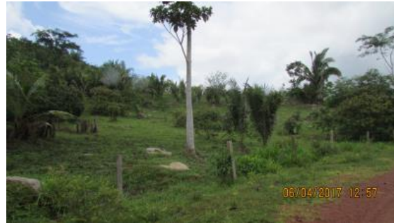
Inspeção trimestral 23 (abril/2017 - cheia): Sem alterações em relação a janeiro/2017. Aparentemente estável sob o ponto de vista geotécnico.
