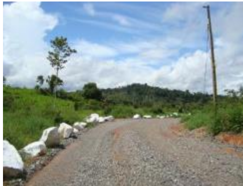
Inspeção Trimestral 5 (maio/2013 - cheia): Área estável, a via de acesso ao local foi revestida com brita, melhorando a capacidade de infiltração.
