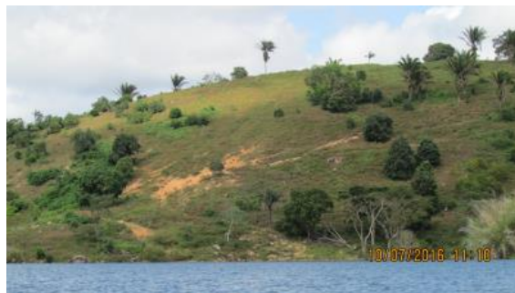
Inspeção trimestral 20 (julho/2016 - vazante): Blocos rochosos na base e no leito do rio submersos. Processo erosivo causado por pisoteio do gado, aparentemente estável.
