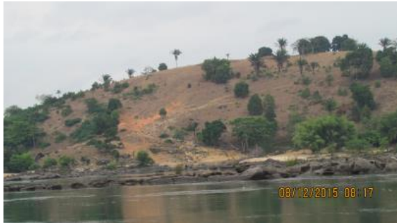
Inspeção 16 (dezembro/2015 - enchente): Exposição dos blocos rochosos na base do talude e no leito do rio. Processo erosivo, causado por pisoteio do gado, aparentemente estável.
