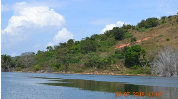
Inspeção trimestral 28 (julho/2018 - vazante): Blocos rochosos, na base e no leito do rio, levemente expostos devido ao rebaixamento do nível da água. Situação geotécnica semelhante ao observado no mesmo período do ano de 2017.
