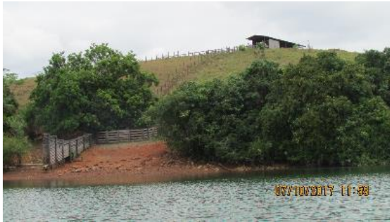
Inspeção trimestral 25 (outubro/2017 - seca): Zona de praia e talude mais expostos devido ao período de seca.
