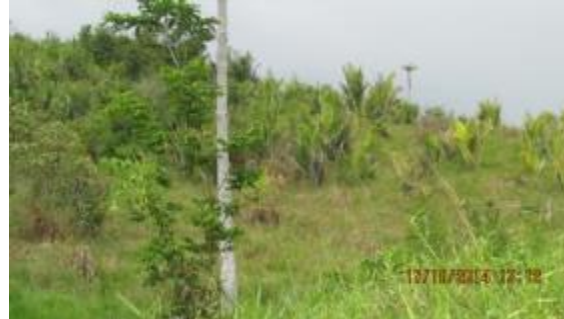
Inspeção Trimestral 11 (outubro/2014 - seca): Área aparentemente estável.
