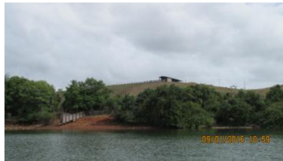
Inspeção trimestral 17 (janeiro/2016 - enchente): Sem alteração significativa em relação a dezembro/2015.
