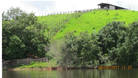
Inspeção trimestral 23 (abril/2017 - cheia): Zona de praia e talude submersos devido ao período de cheia. Aparentemente estável sob o ponto de vista geotécnico.
