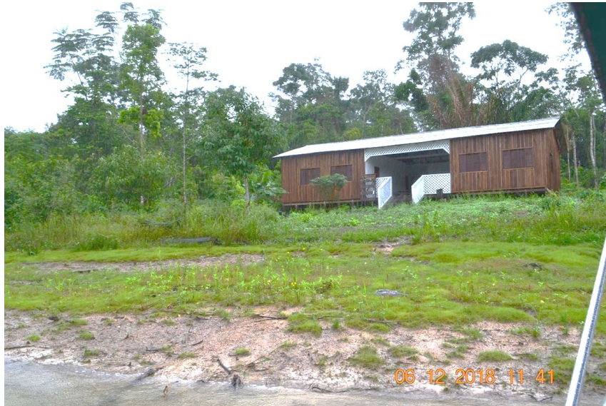
Figura 10.3 - 5 – Aspecto geral do talude do Ponto 5 (Ponto R58) durante a inspeção de dezembro de 2018, onde se constata as boas condições geotécnicas da encosta marginal.
