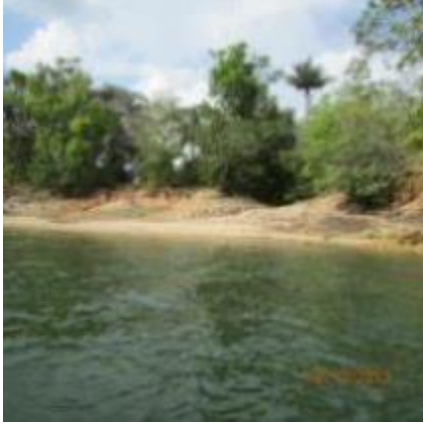
Inspeção Trimestral 7 (outubro/2013 - seca): Aumento da zona de praia devido à redução de nível do rio Xingu. Semelhante aos casos exemplificados anteriormente, sem mudanças perceptíveis do risco geotécnico original.
