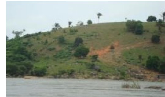
Inspeção Trimestral 12 (janeiro/2015 - enchente): Área potencialmente estável. Nota-se aumento da vegetação na encosta e menor exposição das rochas próximas à margem, devido ao aumento do nível do rio Xingu. Pouca diferenciação de características em relação às visitas anteriores em épocas similares.
