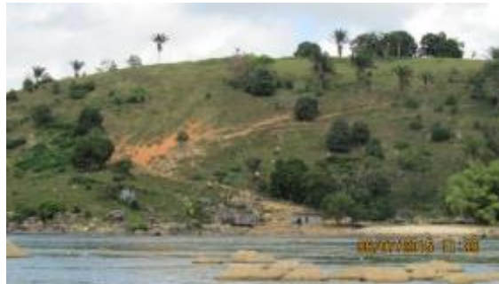
Inspeção Trimestral 14 (julho/2015 - vazante): Área aparentemente estável. Diminuição do nível do rio, com o aumento da exposição dos blocos rochosos na base do morro.
