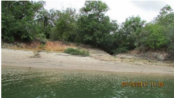
Inspeção trimestral 25 (outubro/2017 - seca): Zona de praia, talude e blocos rochosos mais expostos devido ao período de seca. Sem relação com o empreendimento de Belo Monte.
