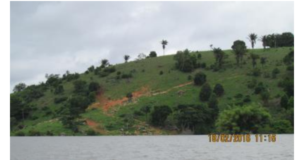
Inspeção 18 (fevereiro/2016 - enchente): Blocos rochosos, na base e no leito do rio, submersos. Processo erosivo, causado por pisoteio do gado, aparentemente estável.
