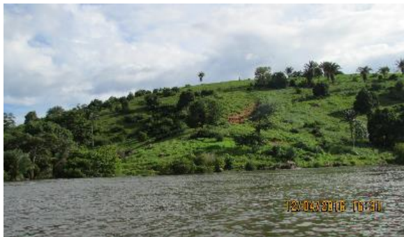
Inspeção trimestral 19 (abril/2016 - cheia): Em relação a fevereiro/2016, se observa maior densidade de gramíneas.
