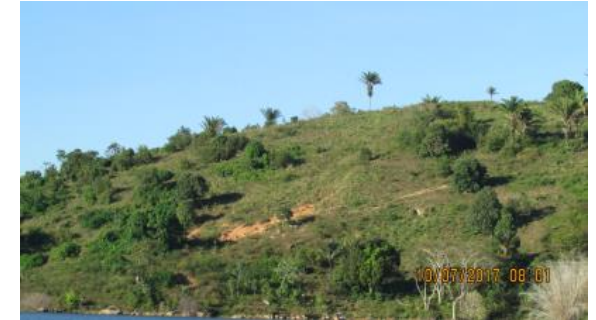
Inspeção trimestral 24 (julho/2017 - vazante): Blocos rochosos na base e no leito do rio, levemente expostos devido ao rebaixamento do nível da água.
