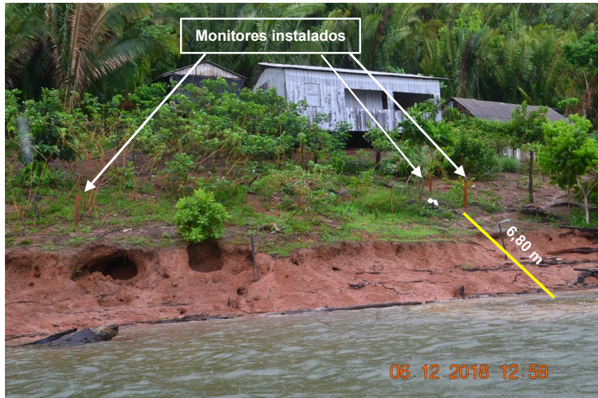
Figura 10.3 - 8 – Aspecto geral do talude do Ponto 7 (Ponto R60) durante a inspeção de dezembro, com indicação dos monitores instalados.
