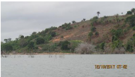
Inspeção trimestral 25 (outubro/2017 - seca): Blocos rochosos na base e no leito do rio, mais expostos devido ao rebaixamento do nível de água. O monitoramento deve ser continuado.
