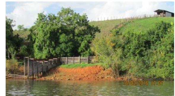
Inspeção 18 (fevereiro/2016 - enchente): Zona de praia arenosa submersa. Ponto utilizado como embarcadouro de animais de corte à margem do rio.
