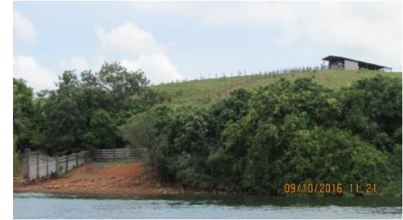
Inspeção trimestral 21 (outubro/2016 - seca): Talude mais exposto devido ao rebaixamento do nível do rio. Condições similares às visitas anteriores.
