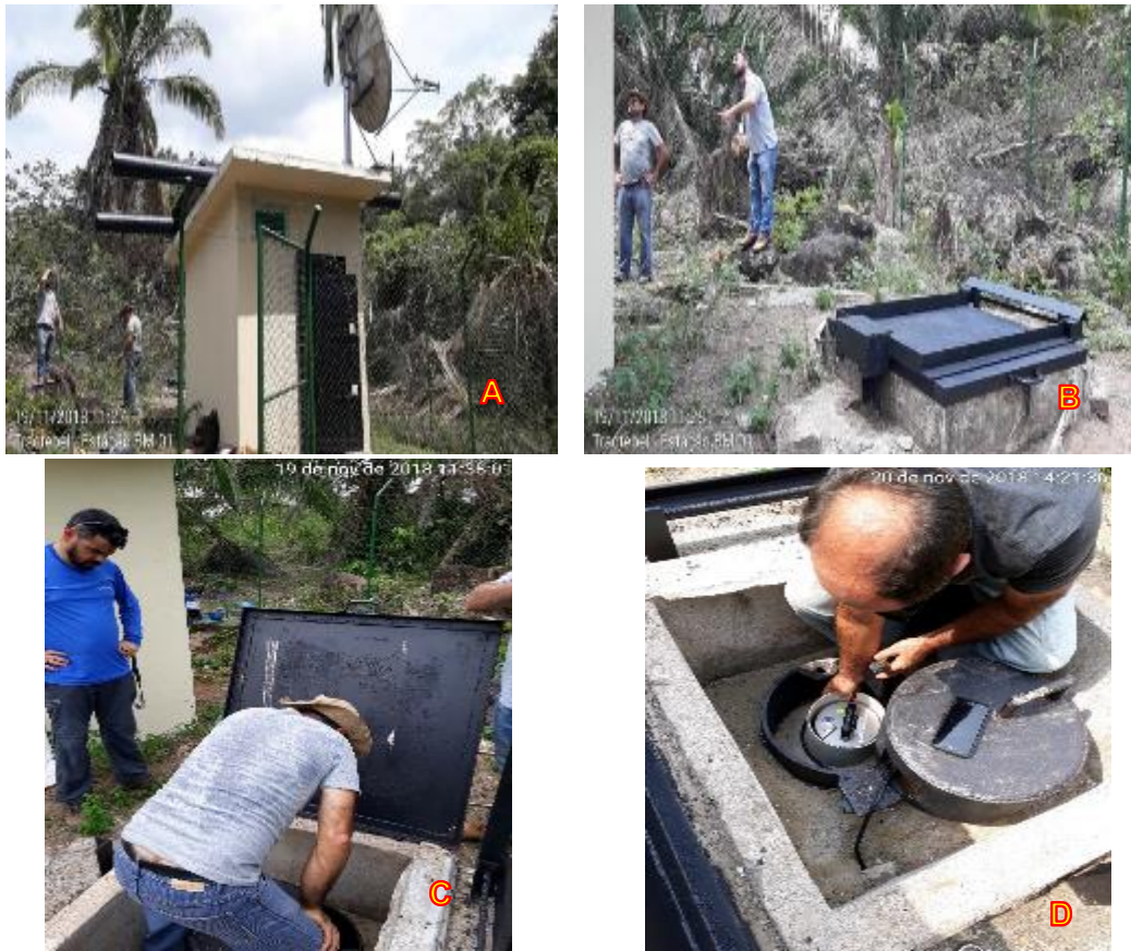
Figura 10.1 - 1 – Aspectos gerais das atividades de reinstalação da estação BM 01 (19 e 20 de novembro de 2018): (A) Vista geral da estação BM01; (B) Detalhe da proteção construída para abrigar o sismômetro; (C) Instalação do sismômetro; e (D) Teste de aferição do sismômetro.
