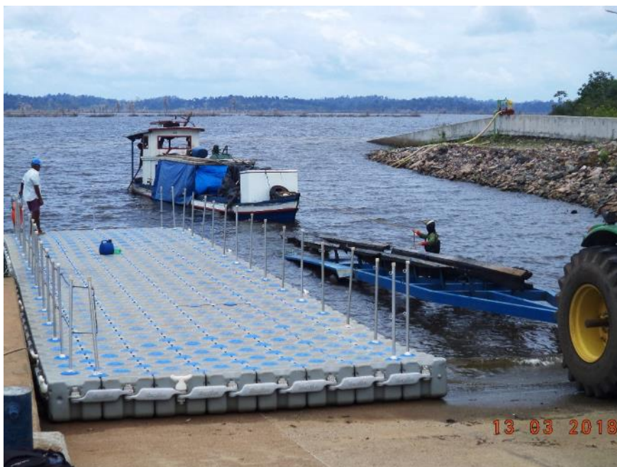
Figura 14.2.4 - 15 – Plataforma flutuante utilizada nas estruturas do Sistema de Transposição de Embarcações (STE) da UHE Belo Monte para embarque e desembarque de usuários das embarcações.
