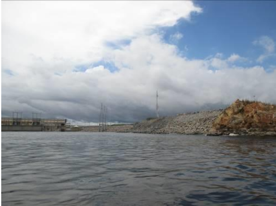
Foto - 1 – Vista geral do ponto de monitoramento SEPIM em maio de 2018
