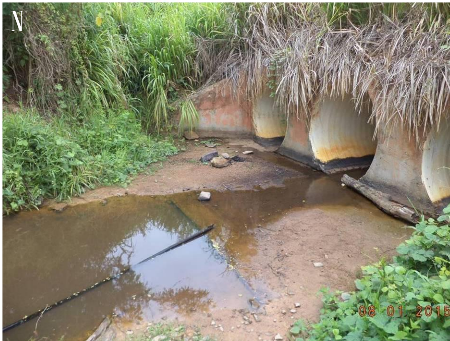
Foto - 1 – Vista do ponto de coleta limnológica no igarapé Paquiçamba a montante do Travessão km 27 e do canteiro Canal e Diques. Observa-se baixa vazão do igarapé devido à pouca precipitação na região na coleta de janeiro de 2015
