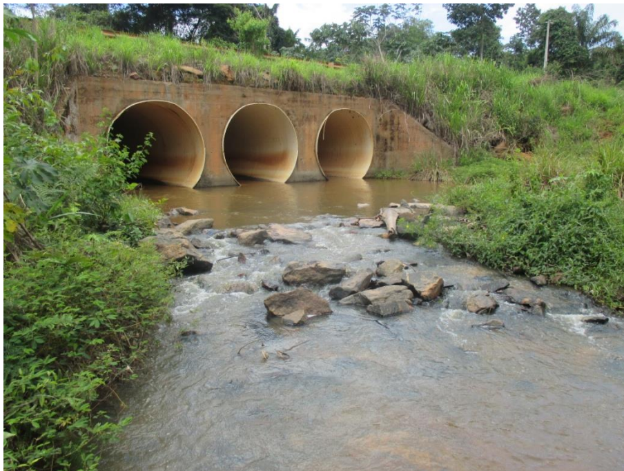
Foto - 2 – Vista do igarapé Santo Antônio no local de monitoramento em janeiro de 2018, correspondente ao período de enchente
