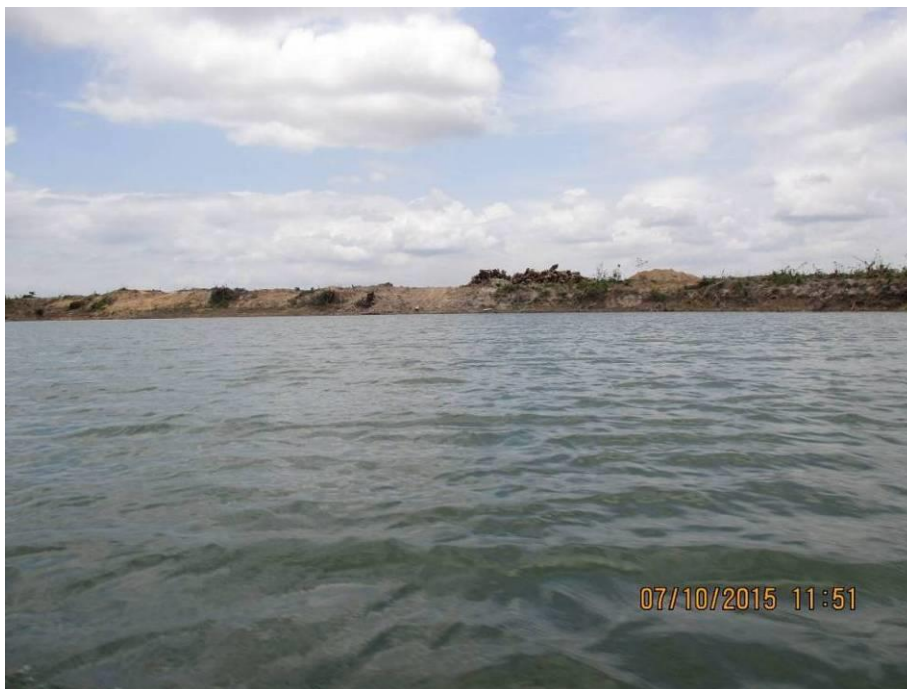
Foto - 1 – Vista geral do ponto Pimental, localizado no rio Xingu logo a montante do eixo da Barragem Principal (Pimental) em outubro de 2015
