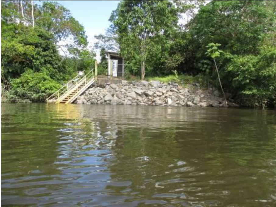
Foto - 1 – Vista do ponto CAPTAÇÃO BELO MONTE na campanha de maio de 2018
