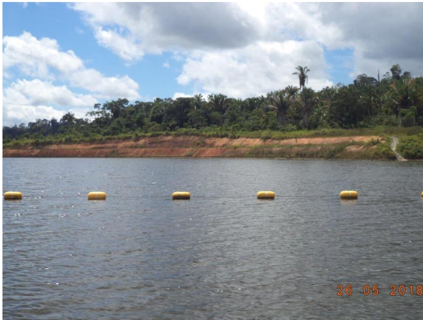
Figura 14.2.4 - 11 – Sinalização a montante do Canal de Derivação.
