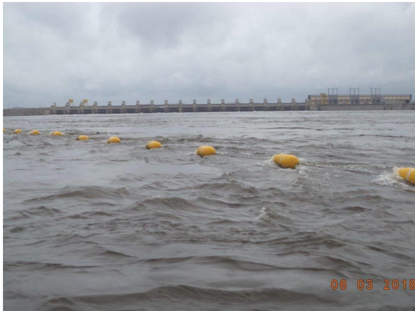
Figura 14.2.4 – 10 – Sinalização a jusante do Vertedouro da UHE Pimental.
