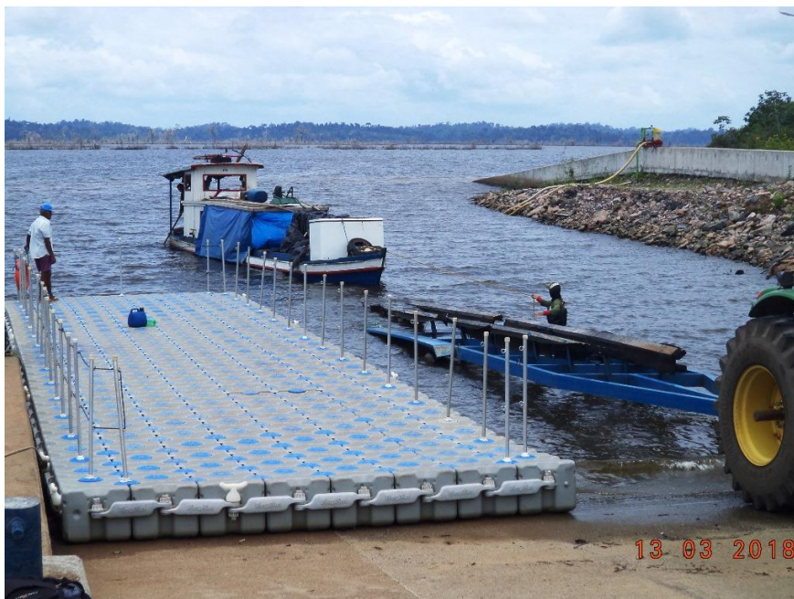
Figura 14.2.4 - 3 – Plataforma flutuante utilizada nas estruturas do Sistema de Transposição de Embarcações (STE) da UHE Belo Monte para embarque e desembarque de usuários das embarcações.
