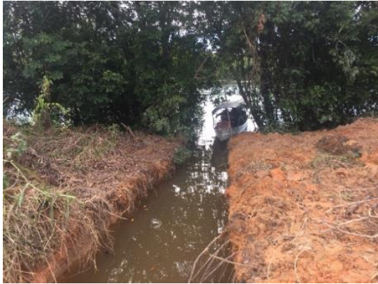
Figura 14.1.1-10 – Vala aberta para possibilitar captação de água para a moagem no Garimpo Ouro Verde (março/2018). Coord. UTM: 395.551E / 9.604.801N.
