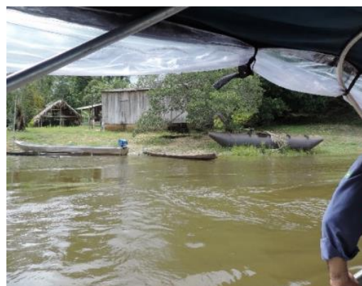
Figura 14.1.1-19– Tubo de aço de suporte basal de balsa, em deterioração, na localidade São Jerônimo, em março/2018. Coord. UTM: 424.982E / 9.604.959N.
