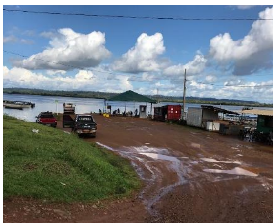
Figura 13.3.5-57 – Visão geral da área do Porto das Carroças – Tenda de trabalho – carros de transporte das tralhas - 05/06/2018
