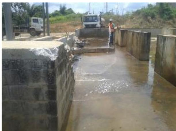
**Figura 32:** Funcionários realizando o enxague da área da tancagem após a lavagem de descontaminação.
