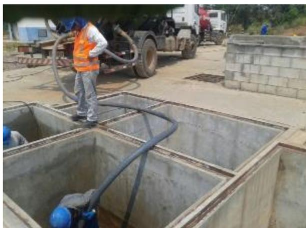
**Figura 36:** Funcionários realizando a sucção do efluente proveniente da lavagem da estrutura CSAO.
