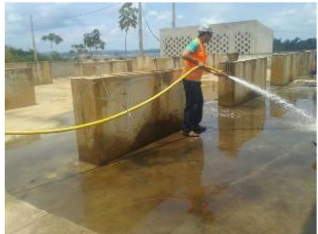
**Figura 31:** Funcionários realizando o enxague da área após a lavagem de descontaminação.
