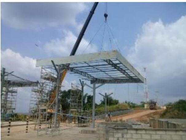
**Figura 22:** Acompanhamento da atividade de remoção da estrutura de cobertura do Posto de Combustível.
