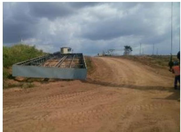
**Figura 23:** Acompanhamento da atividade de remoção da estrutura de cobertura do Posto de Combustível.
