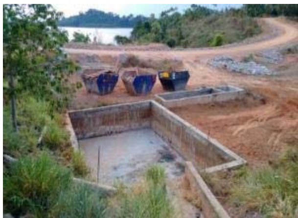
Figura 33: Visão da primeira etapa de tratamento da CSAO.
