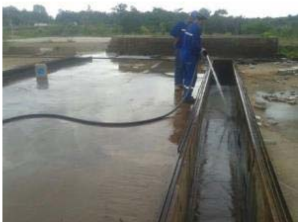
Figura 19: Evidência da lavagem e descontaminação das canaletas, com aplicação de desencrustante Master D-10 e Acido CP.
