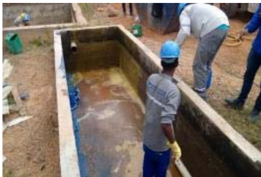
Figura 27: Evidência de aplicação do desencrustante Master D-10, no processo e descontaminação da CSAO.
