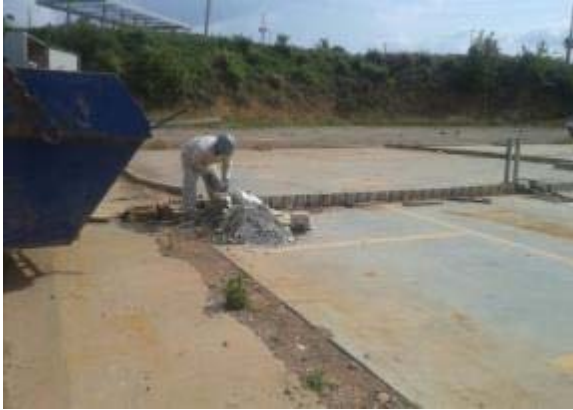
Figura 13: Remoção dos resíduos sólidos, após a retirada dos equipamentos e estruturas da área.
