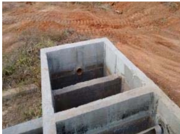
Figura 34: Visão da segunda etapa de tratamento da CSAO.
