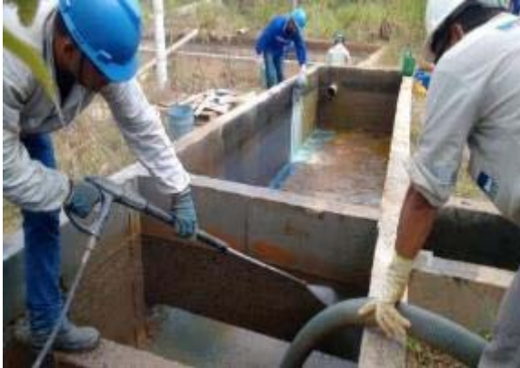
Figura 29: Realização do enxague da estrutura, fazendo o uso da bomba de alta pressão.
