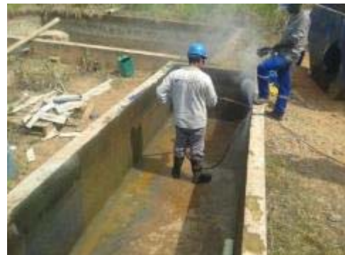
Figura 28: Realização do enxague da estrutura, fazendo o uso da bomba de alta pressão.
