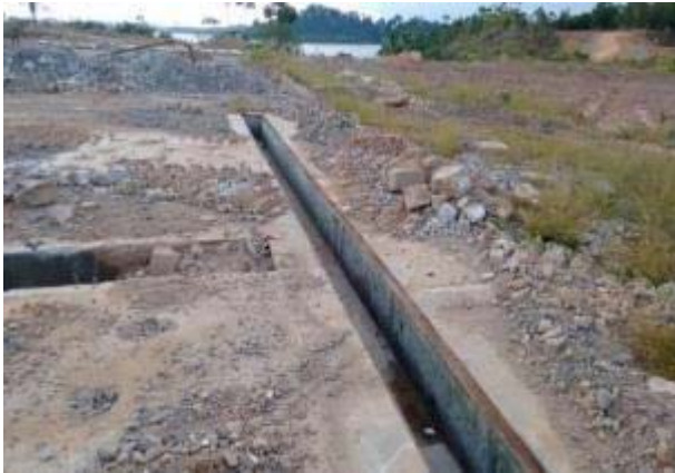
Figura 37: Canaletas, no início do processo de desmobilização.
