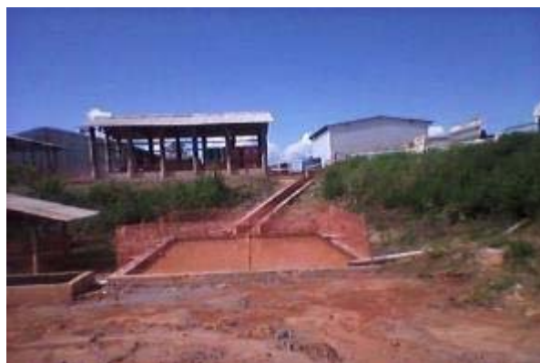
Figura 02: Vista do sistema de tratamento de efluentes industriais: canaleta, bacia de sedimentação e caixa S.A.O.
