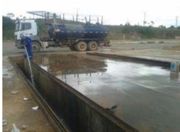
Figura 20: Evidência da lavagem e descontaminação das canaletas com aplicação de desencrustante Master D-10 e Acido CP-3000.
