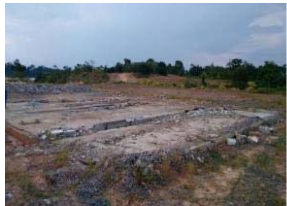
Figura 38: Visão das estruturas de pisos da oficina durante o processo de desmobilização.
