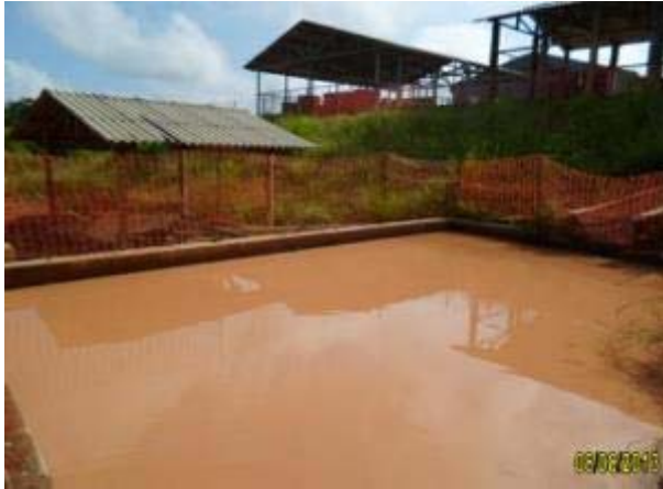
Figura 09: Bacia de sedimentação de efluentes industriais.
