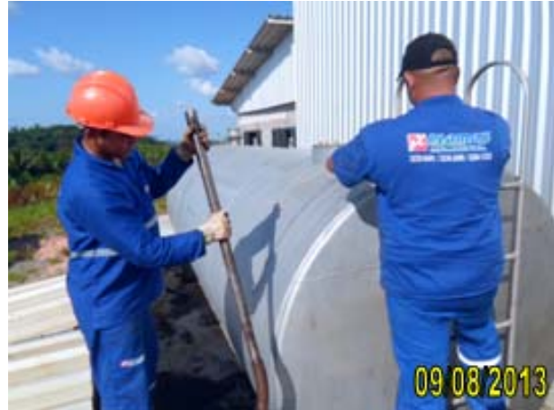
Figura 10: Tanque de acondicionamento de óleo usado, gerado nas trocas de óleo das manutenções preventivas e corretivas dos equipamentos.
