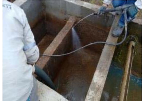
Figura 30: Realização do enxague da estrutura, fazendo o uso da bomba de alta pressão.
