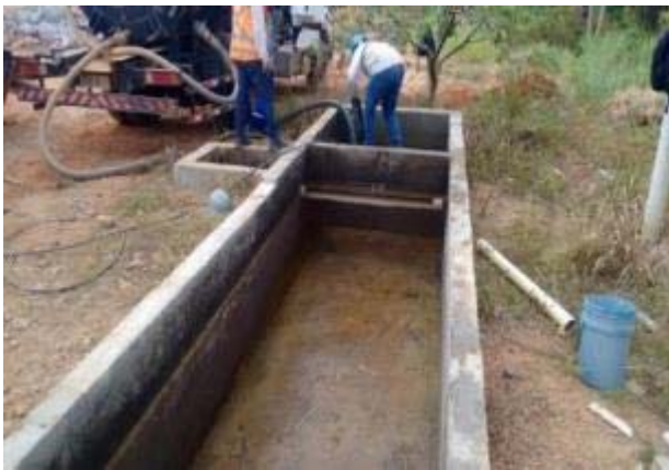
Figura 31: Realização da sucção do efluente da lavagem dos pisos.
