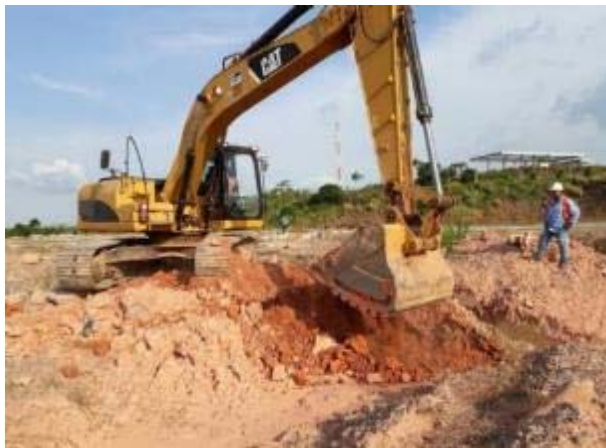
Figura 39: Evidência da realização da escavação para a coleta de solo.
