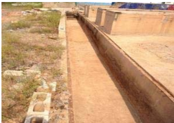
Figura 17: Evidência da canaleta limpa, livre de sedimentos, pronta para lavagem e descontaminação;
