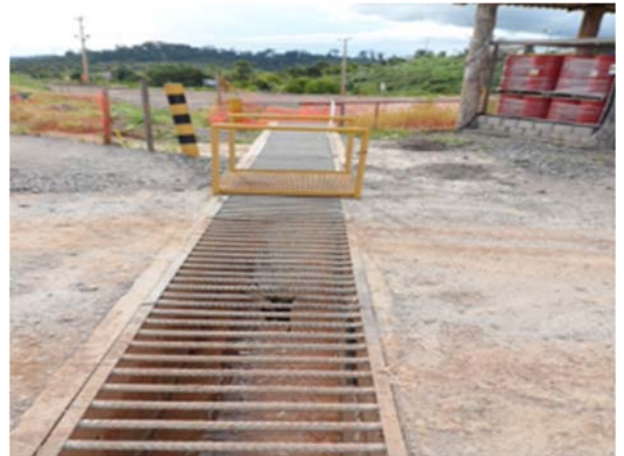
Figura 08: Sistema de drenagem (canaletas) em torno de toda a estrutura.
