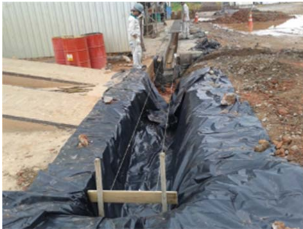
Figura 07: Processo de construção das canaletas.
