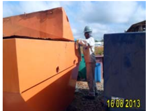
Figura 12: Disponibilização de caçambas brook durante toda a operação da oficina, visando a correta segregação dos resíduos gerados nas atividades.
