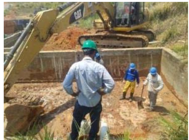
Figura 24: Evidência da retirada dos sólidos do interior da caixa de acumulação, com equipamentos manuais.
