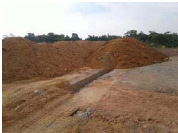
Figura 42: Reconformação área oficina mecânica, lubrificação e rampa de lavagem, após resultados satisfatórios dos laudos de análise do solo.
