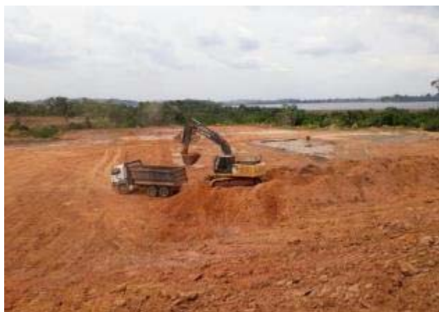
Figura 41: Reconformação área oficina mecânica, lubrificação e rampa de lavagem, após resultados satisfatórios dos laudos de análise do solo.
