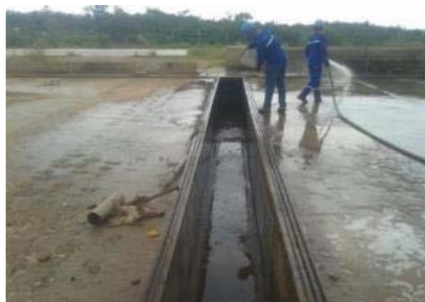
Figura 18: Evidência da lavagem e descontaminação dos pisos, com aplicação de desencrustante Master D-10 e Acido CP-3000 ;
