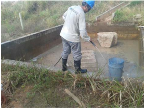
Figura 25: Evidência da repetição da aplicação do Acido CP-3000, visando retirada de todo o contaminante do piso da estrutura.
