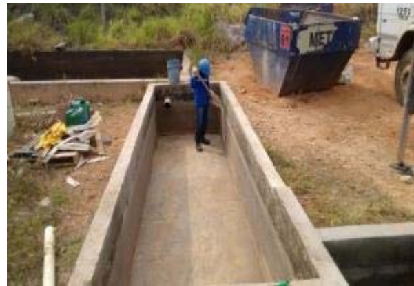
Figura 32: Realização de raspagem das paredes da estrutura, visando a remoção de todo e qualquer vestígio de contaminante.
