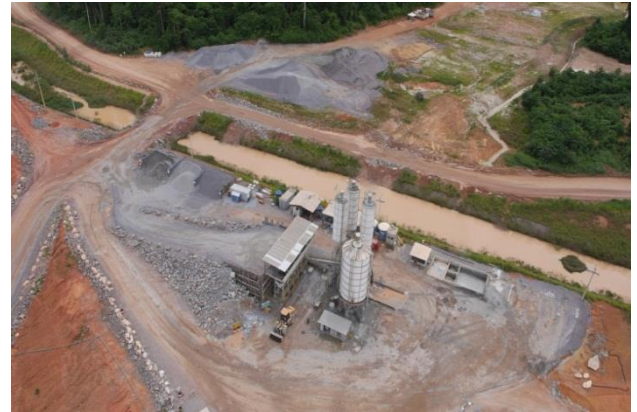
Figura 02: Vista da Bacia de sedimentação e silos.
