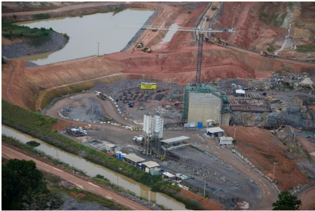
Figura 01: Vista da Central de Concreto – Canais.
