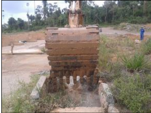
Figura 19: Atividade de quebra da estrutura da rampa de sedimentação.
