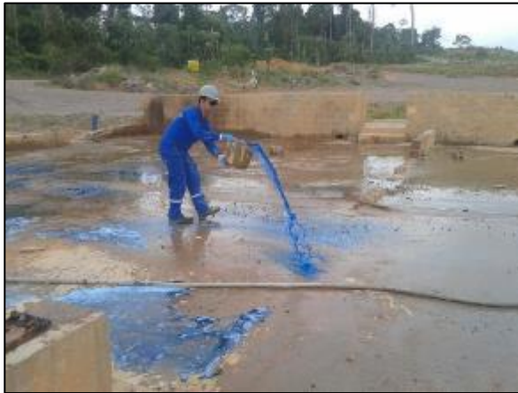
Figura 09: Aplicação de desencrustante para descontaminação dos pisos;
