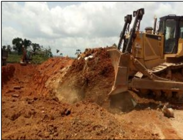
Figura 21: Enterio da estrutura de concreto da oficina;
