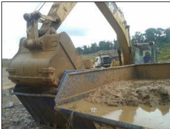
Figura 17: Sedimentos das estruturas sendo acondicionados em caçambas brok;
