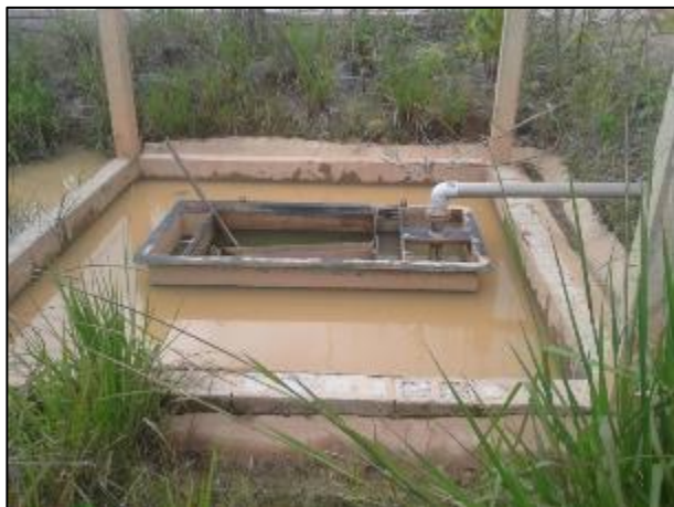
Figura 13: Limpeza da estrutura de CSAO da área;
