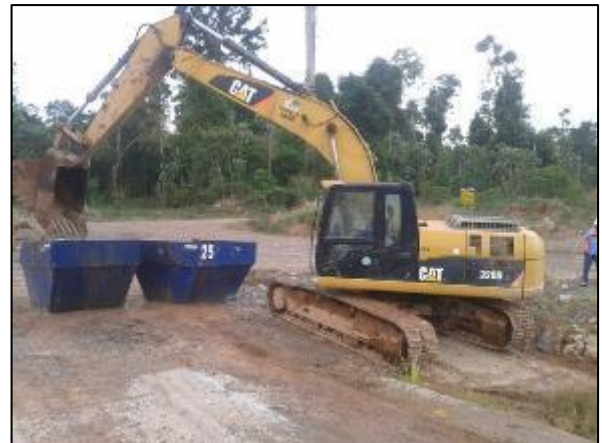
Figura 08: Retirada dos resíduos sólidos dos pisos e canaletas da estrutura;
