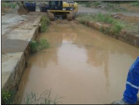
Figura 15: Limpeza da área da rampa de lavagem;
