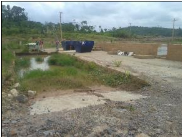
Figura 07: Retirada dos equipamentos e materiais da área;
