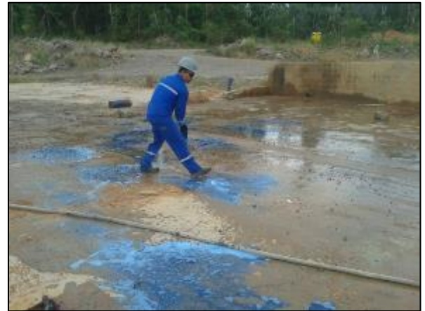
Figura 10: Aplicação de desencrustante para descontaminação dos pisos;
