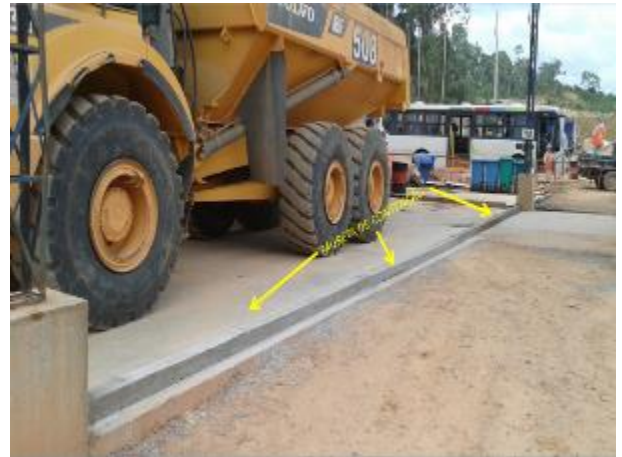
Figura 02: Mutetas de contenção da área de manutenção dos equipamentos.
