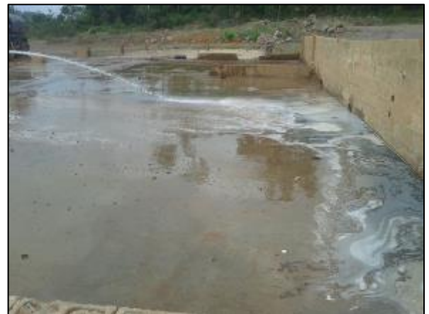
Figura 12: Descontaminação dos pisos das estruturas da oficinas;
