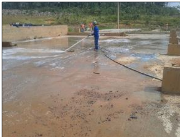
Figura 11: Descontaminação dos pisos das estruturas da oficinas;
