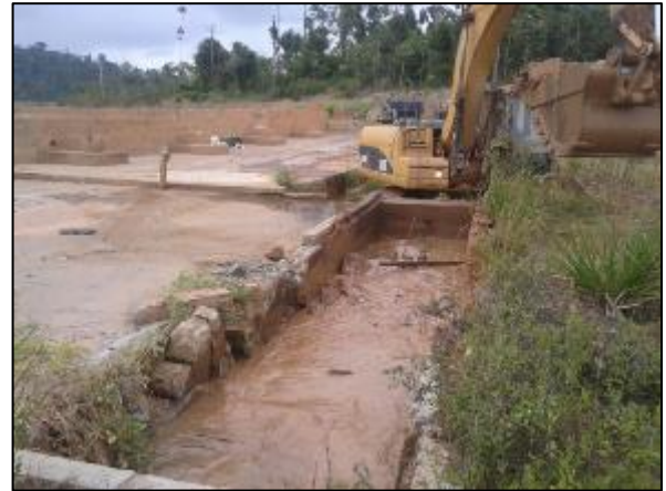
Figura 16: Retirada dos sedimentos da rampa de lavagem;
