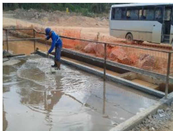
Figura 16: Limpeza da área da rampa de lavagem;
