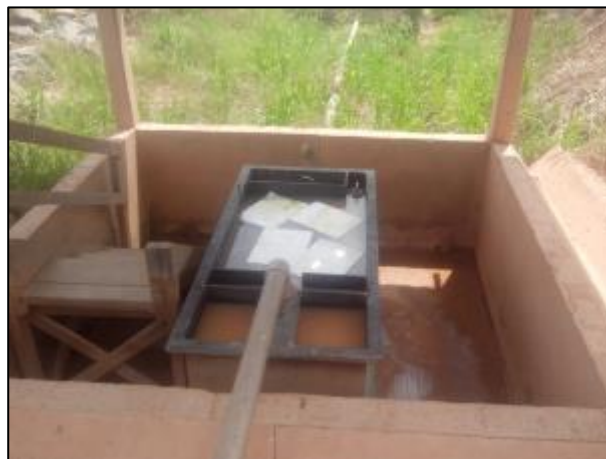
Figura 14: Estrutura de CSAO higienizada, livre de vestígios de resíduo oleoso;
