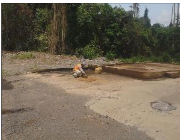
Figura 07: Limpeza do piso conforme PO-CCBM-220-89.
