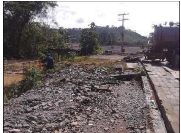
Figura 10: Sucção do efluente da lavagem do piso.
