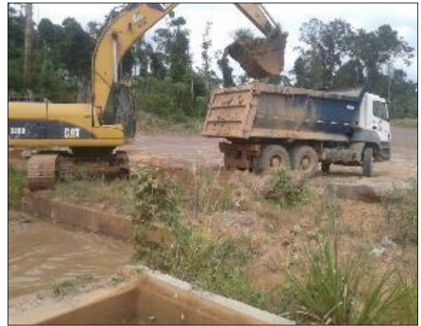
Figura 12: Retirada dos sedimentos da rampa.
