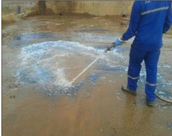
Figura 09: Lavagem do piso para descontaminação.
