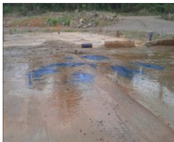
Figura 08: Aplicação de desengraxante no piso da oficina.
