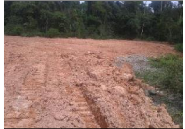
Figura 14: Área sendo reconformada.
