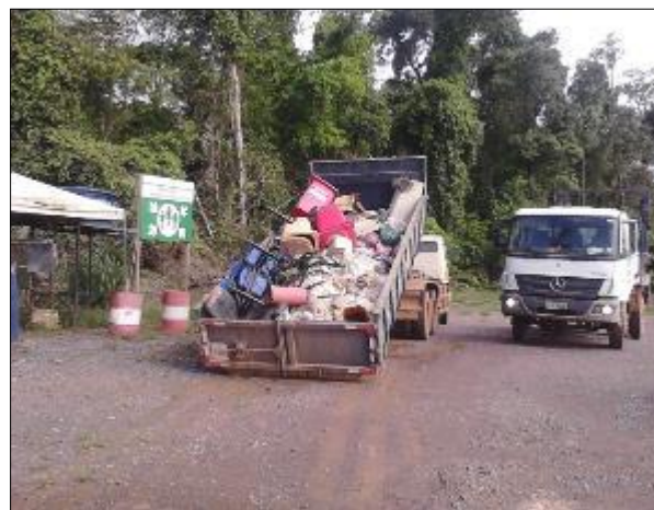
Figura 06: Retirada dos materiais e resíduos da área.
