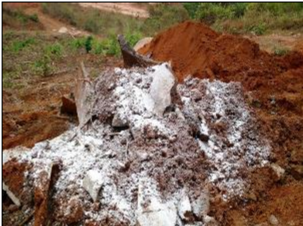
Figura 09: Aplicação de Cal nas Fossas.
