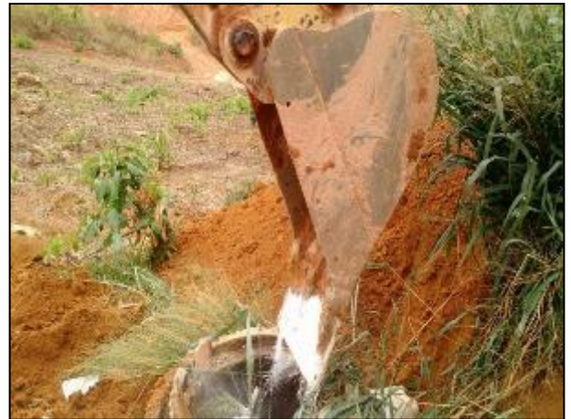
Figura 10: Desmobilização de Fossas.
