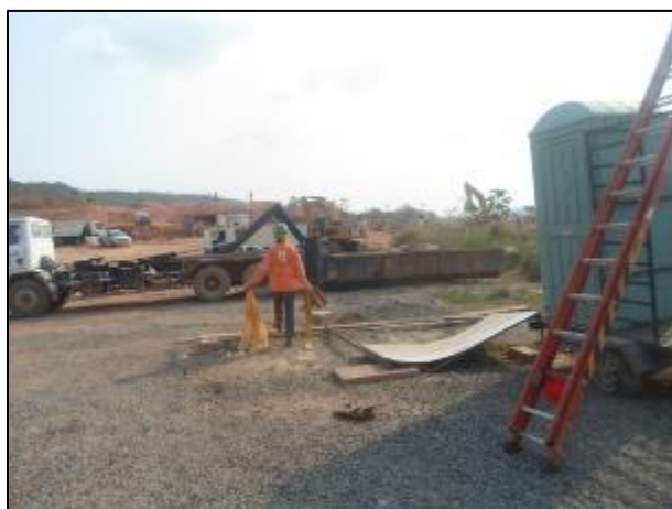
Figura 15: Retirada dos resíduos.
