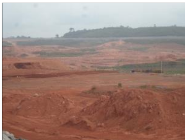
Figura 19: Limpeza da área para o enchimento do reservatório intermediário.
