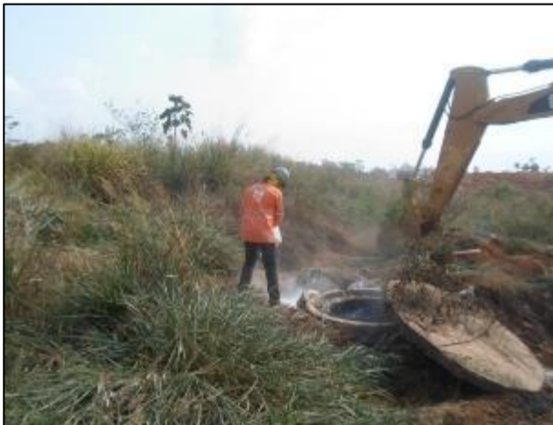
Figura 11: Aplicação de Cal nas Fossas sépticas.
