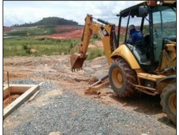
Figura 10: Retirada do piso
