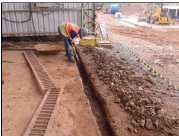
Figura 07: Limpeza de canaletas
