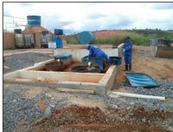
Figura 06: Higienização das estruturas de caixa S.A.O.
