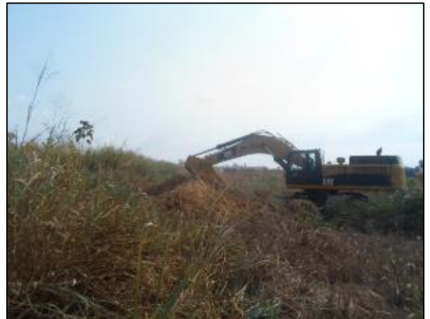
Figura 12: Desmobilização de Fossas.
