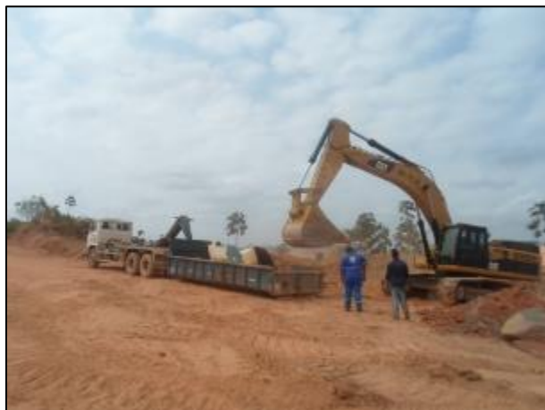
Figura 17: Transporte de materiais e resíduos.
