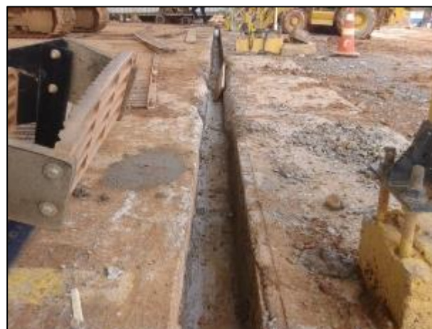
Figura 08: Limpeza de canaletas
