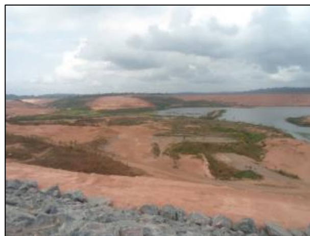
Figura 20: Enchimento do reservatório intermediário e alagamento da área da oficina.
