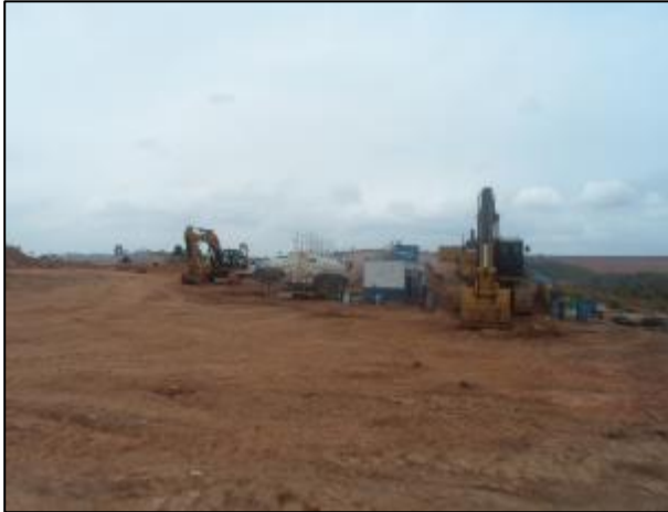
Figura 09: Retirada das estruturas
