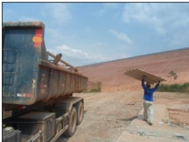
Figura 13: Limpeza da área
