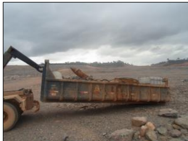
Figura 14: Retirada dos resíduos.
