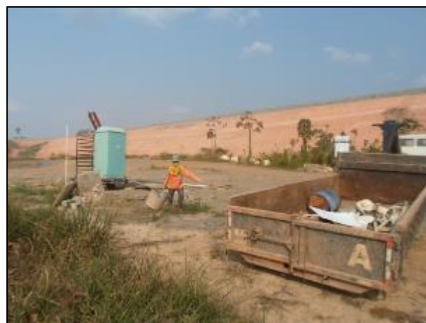
Figura 16: Retirada dos resíduos.
