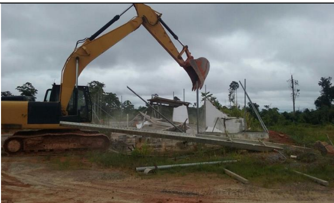
Figura 11 – Remoção do Piso de Concreto.
