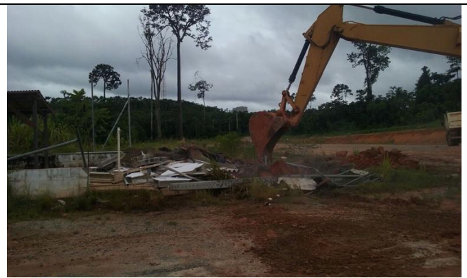
Figura 12 – Remoção do Piso de Concreto.
