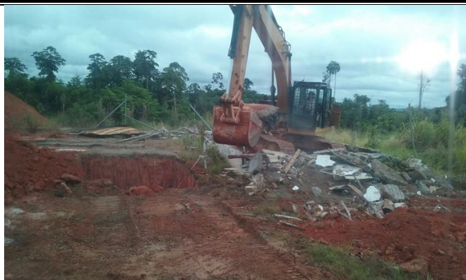
Figura 13 – Remoção da estrutura.
