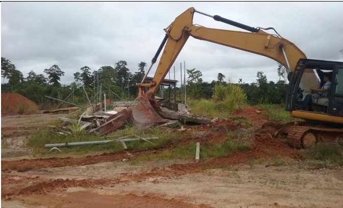
Figura 9 – Remoção do Piso de Concreto..
