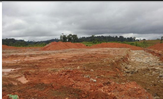
Figura 14 – Local após remoção das estruturas.
