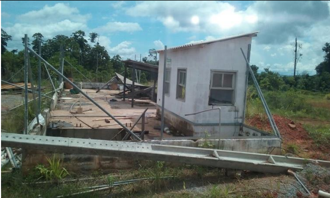
Figura 7 – Remoção do Piso de Concreto.
