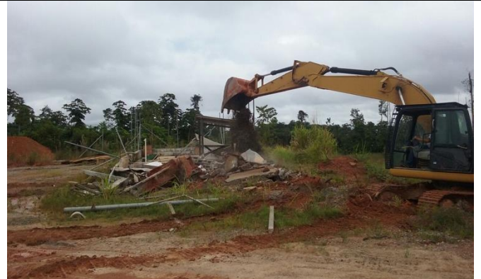
Figura 8 – Remoção do Piso de Concreto..
