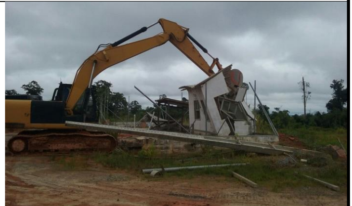
Figura 10 – Remoção do Piso de Concreto.
