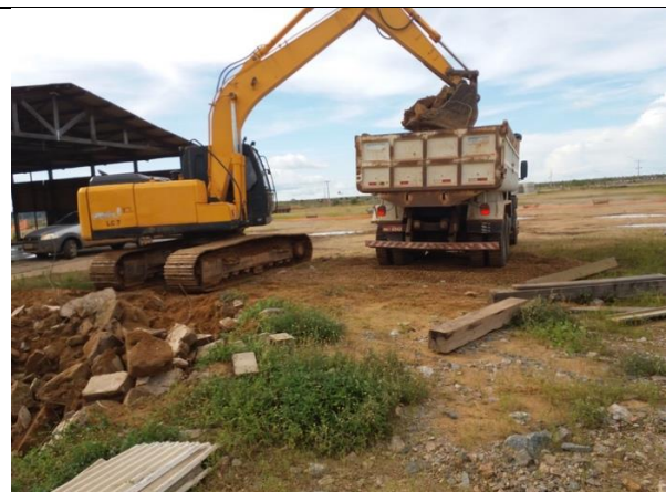
Figura 8 – Data 04-02-2017 - Remoção da estrutura de concreto da Caixa SAO da oficina;
