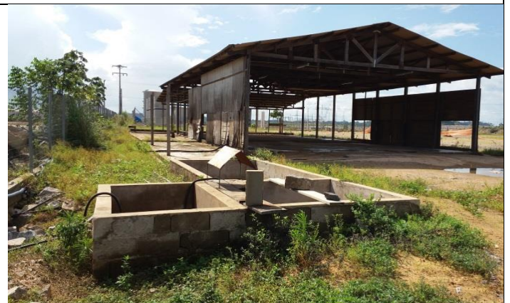
Figura 4 – Data 03-02-2017 - Caixa SAO - Área 1 – Oficina de Manutenção.
