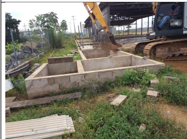
Figura 7 – Data 04-02-2017 - Remoção da estrutura de concreto da Caixa SAO da oficina;
