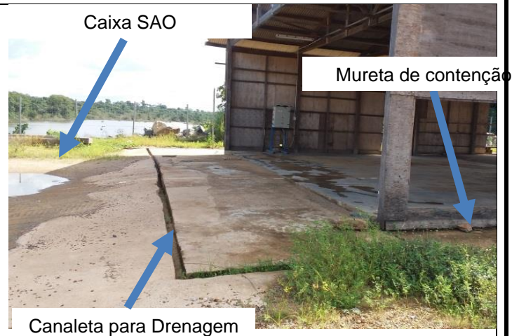
Figura 2 – Data 03-02-2017 - Caixa SAO, muretas e canaleta de contenção da área de manutenção dos equipamentos;
