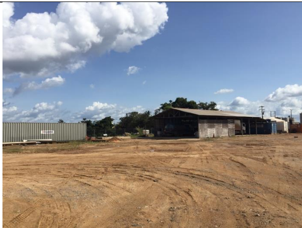
Figura 1 – Data 03-02-2017 - Galpão da Oficina de manutenção mecânica.
