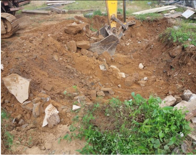
Figura 9 – Data 04-02-2017 - Remoção da estrutura de concreto da Caixa SAO da oficina;
