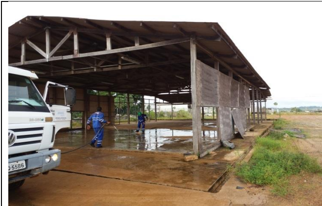
Figura 5 – Data 03-02-2017 - Aplicação de desencrustante para descontaminação dos pisos.
