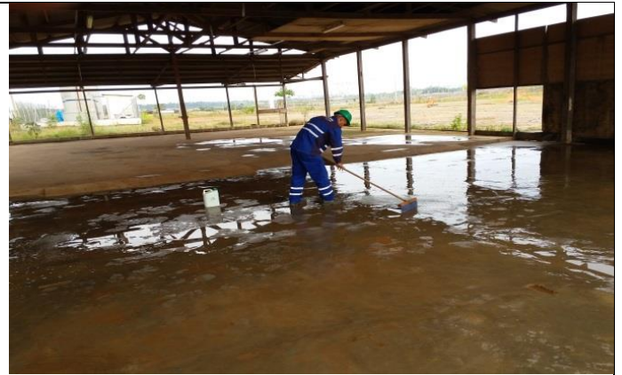
Figura 6 – Data 03-02-2017 - Aplicação de desencrustante para descontaminação dos pisos.
