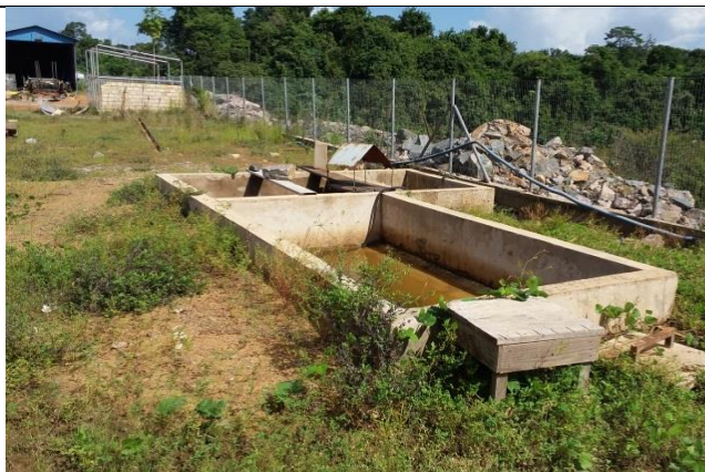
Figura 3 – Data 03-02-2017 - Caixa SAO - Área 1 – Oficina de Manutenção.
