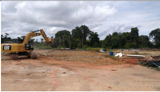
Figura 13 – Remoção do piso de concreto.
