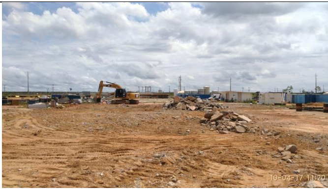
Figura 15 – Remoção do piso de concreto.
