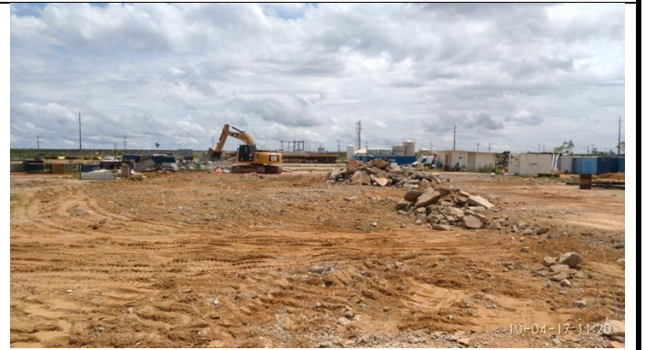
Figura 14 – Remoção do piso de concreto.
