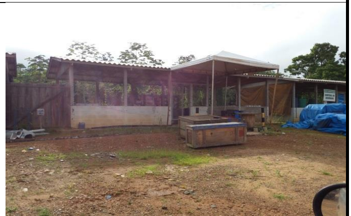
Figura 6 – Data 10.12.2017 – Baía de resíduos contaminados.
