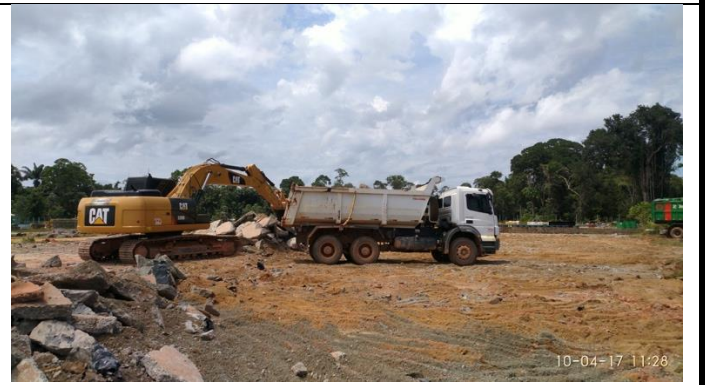
Figura 16 – Remoção do piso de concreto.
