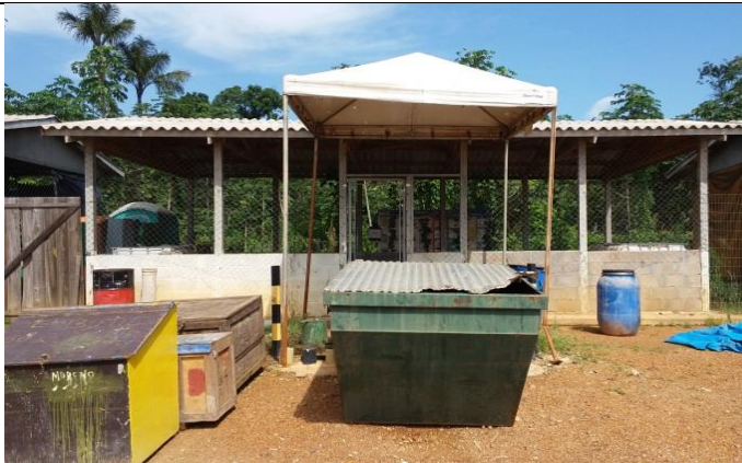
Figura 3 – Data 10.12.2017 – Baía de resíduos contaminados.
