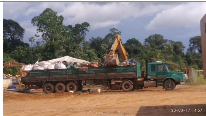
Figura 10 – Data 28.03.2017 – Finalização do carregamento e retirada dos resíduos.
