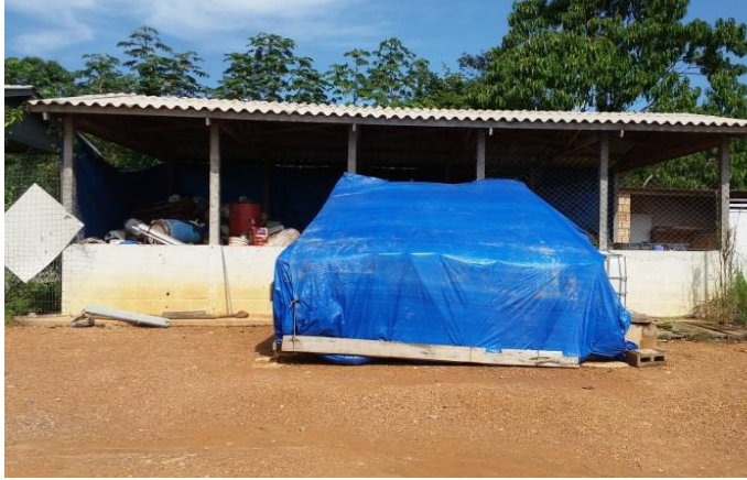
Figura 1 – Data 10.12.2017 – Baía de resíduos contaminados.
